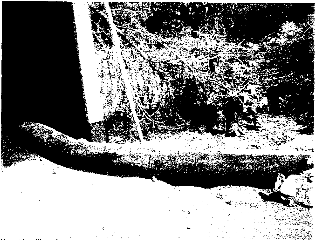
Se está utilizando una manga para evacuar las aguas servidas a un canal.
