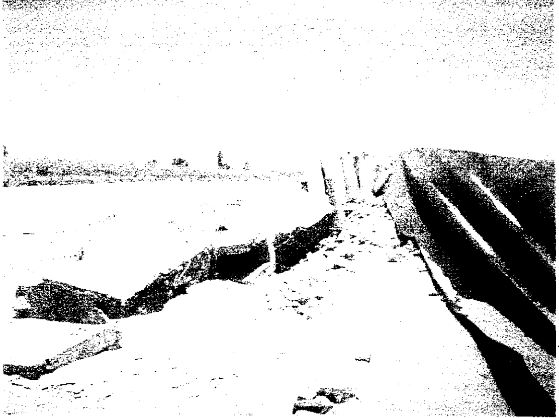
Se observa como ha colapsado un tramo de canal de las lagunas .
