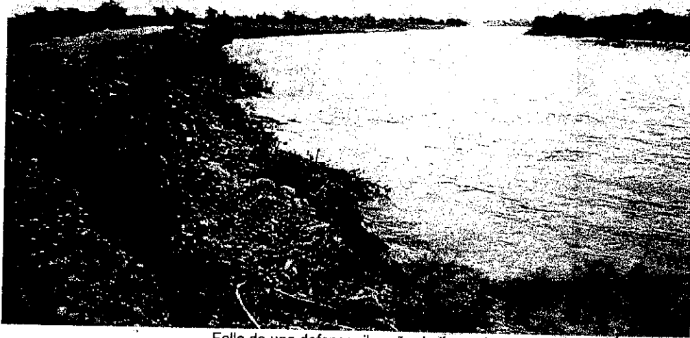
Falla de una defensa ribereña de tierra sin protección
