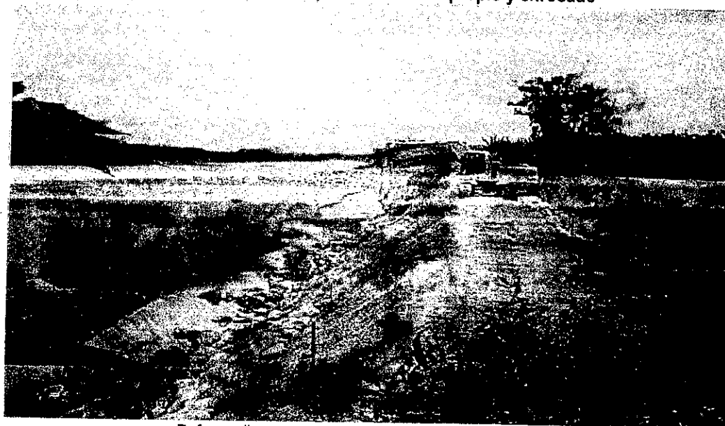
Defensa ribereña, de tierra con protección de enrocado
