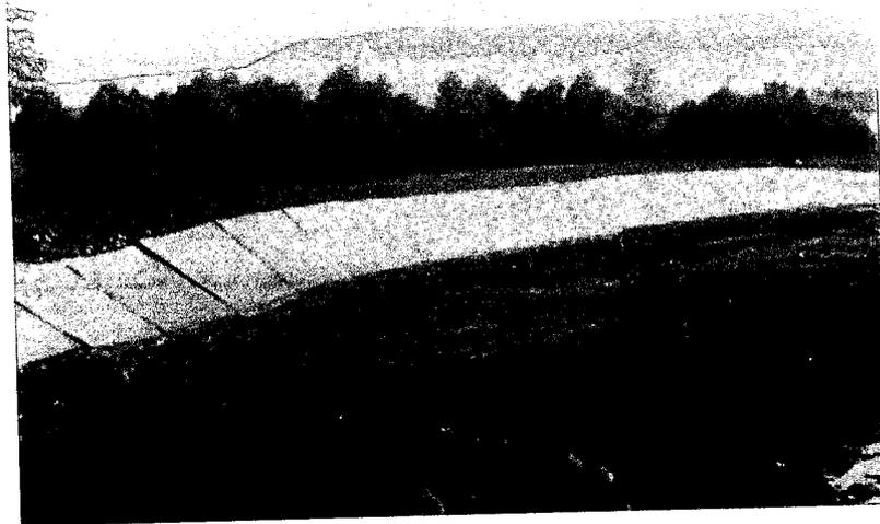
Rio Ica. Falla de revestimiento de concreto por socavación general
