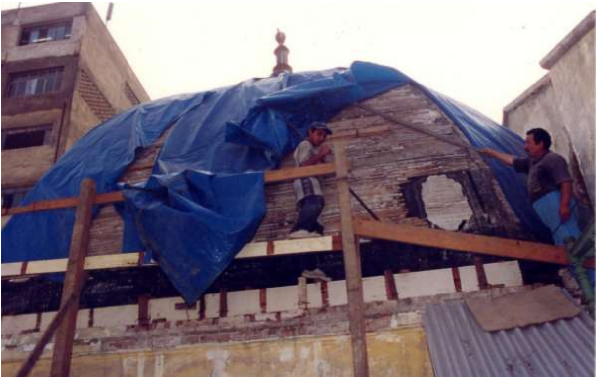
Trabajos de restauración de la cúpula (1998)
