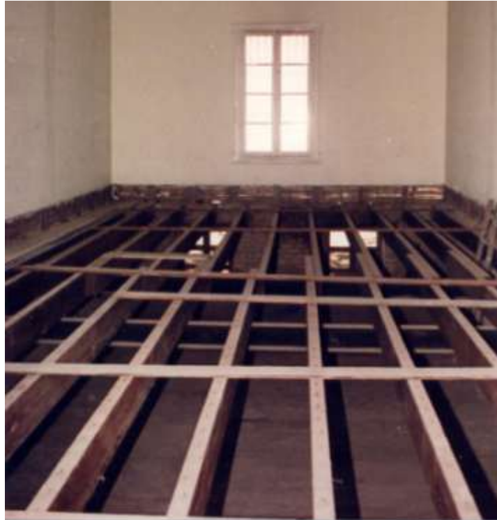
Sala Castilla: restauración del piso
