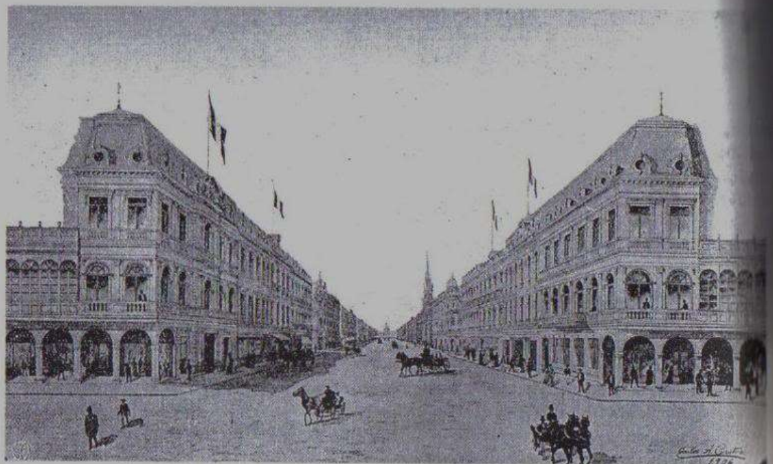
Fig. n° 9. Perspectiva de la avenida 28 de Julio (Memoria de la Municipalidad de Lima, 1906)
