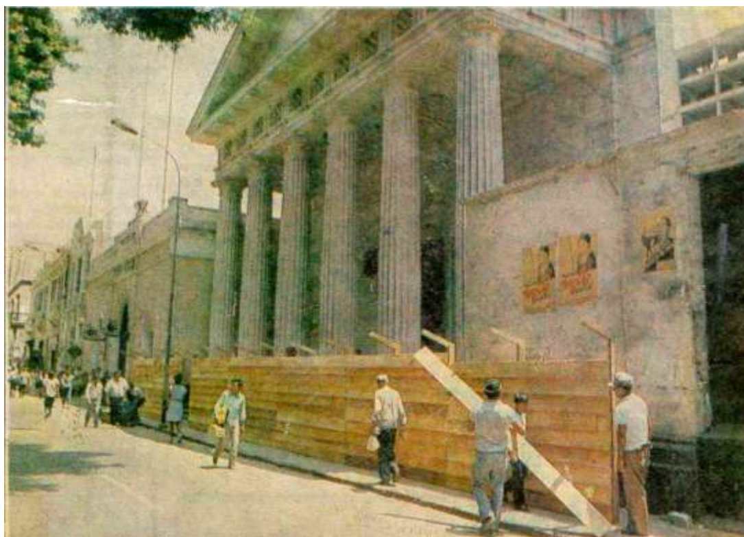
Fachada del Museo del Congreso. Obsérvese el cerco perimétrico colocado para proceder a la demolición (1989).
