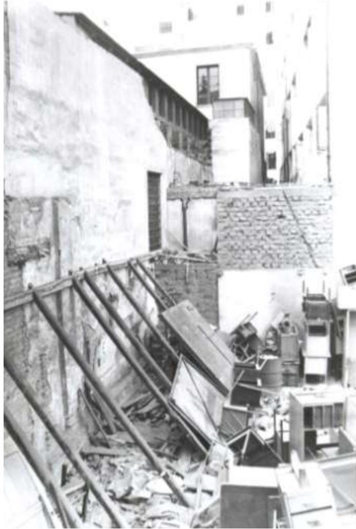
Muro lateral de la Sala de Audiencias
