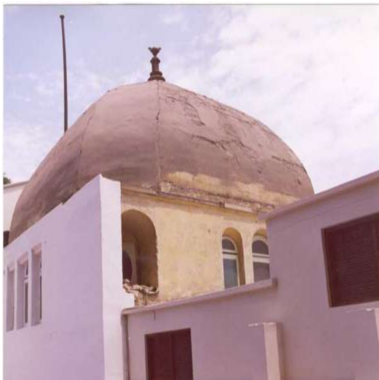
Cúpula del Museo antes de la restauración (1997)
