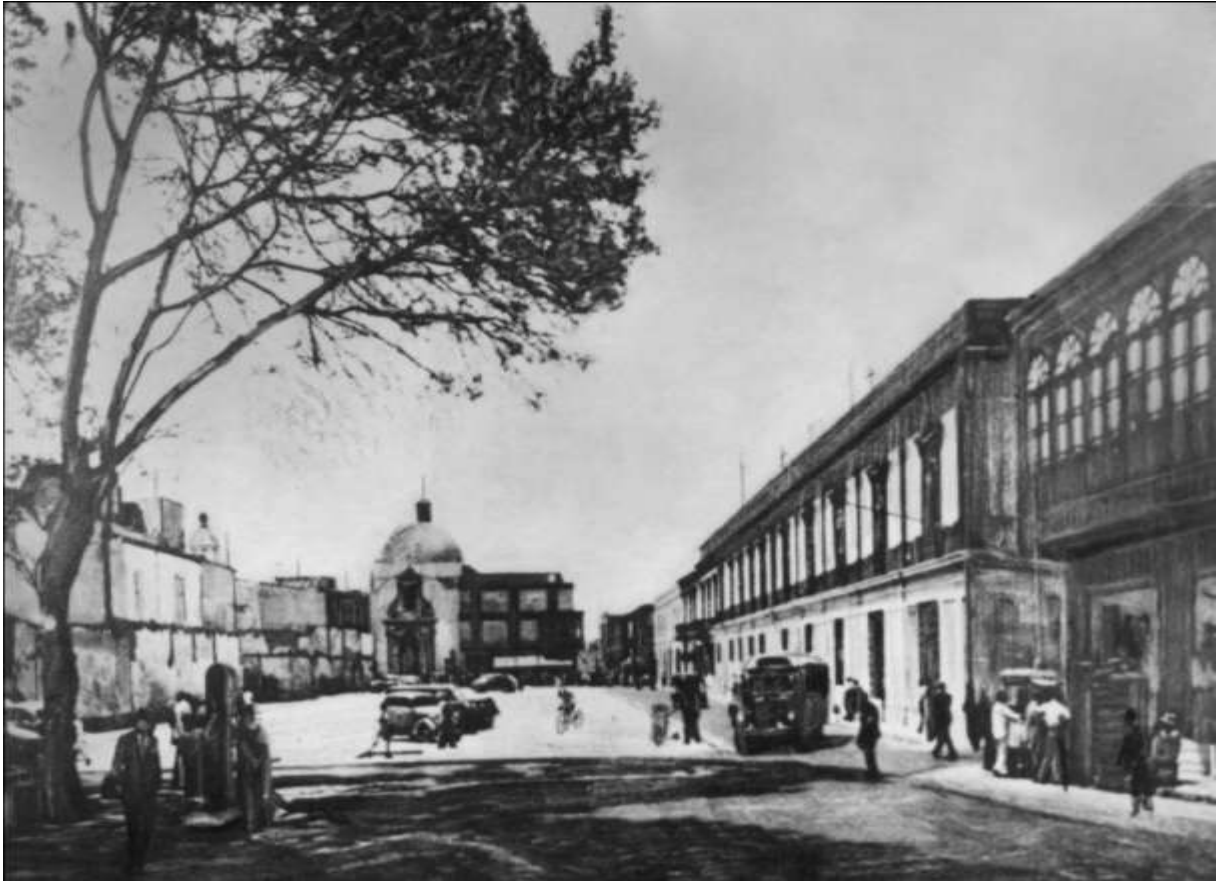
Construcción de la avenida Abancay (esquina con el jirón Junín)
