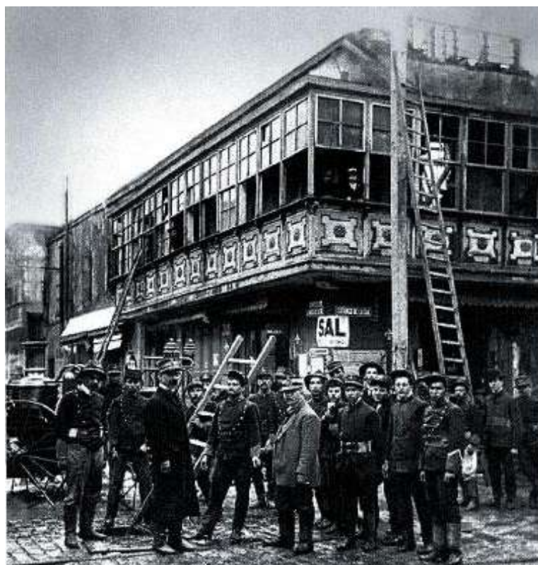
Incendio de la calle Plumereros
