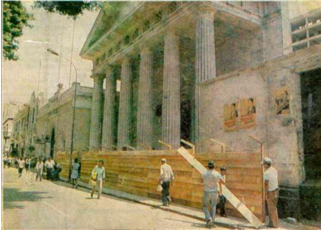
Fachada del Museo del Congreso. Obsérvese el cerco perimétrico colocado para proceder a la demolición (1989).
