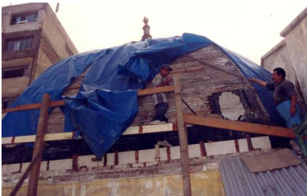
Trabajos de restauración de la cúpula (1998)
