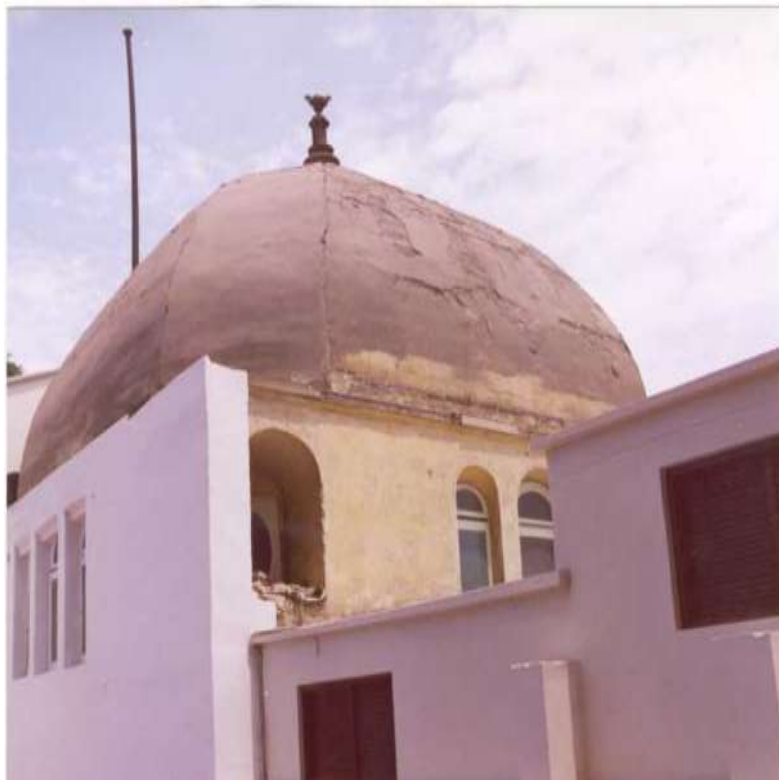
Cúpula del Museo antes de la restauración (1997)
