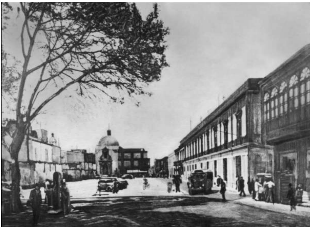
Construcción de la avenida Abancay (esquina con el jirón Junín)
