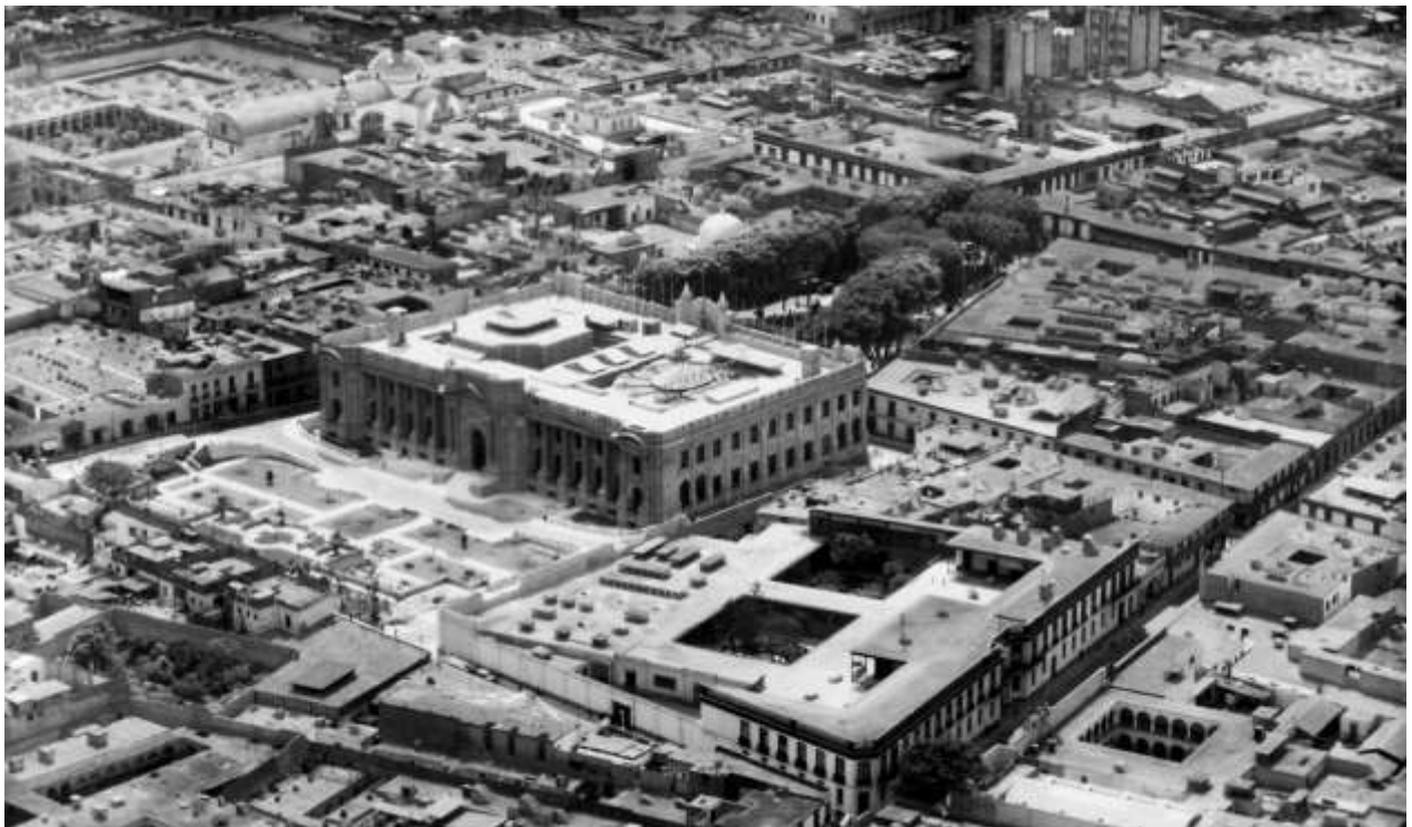
Vista aérea del Palacio Legislativo. Obsérvese la forma triangular de la Plaza Bolívar.
