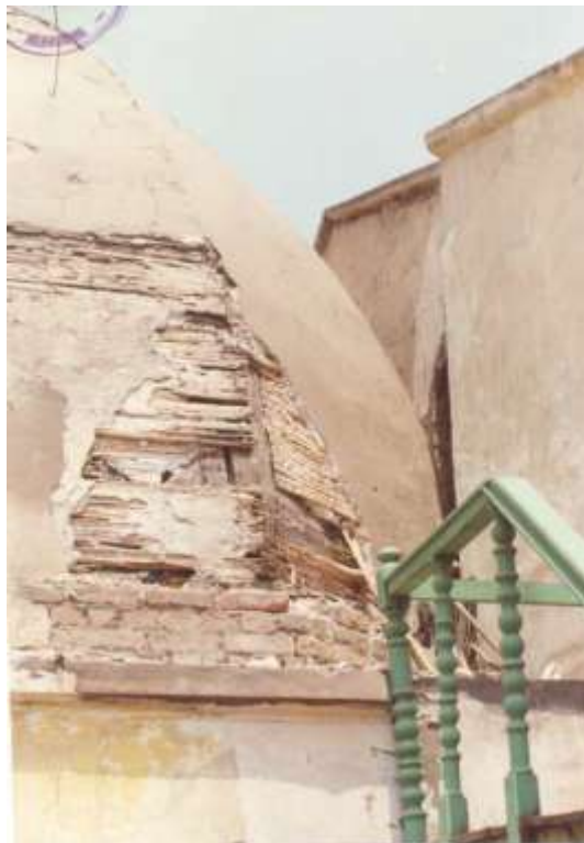
Cúpula de ingreso
