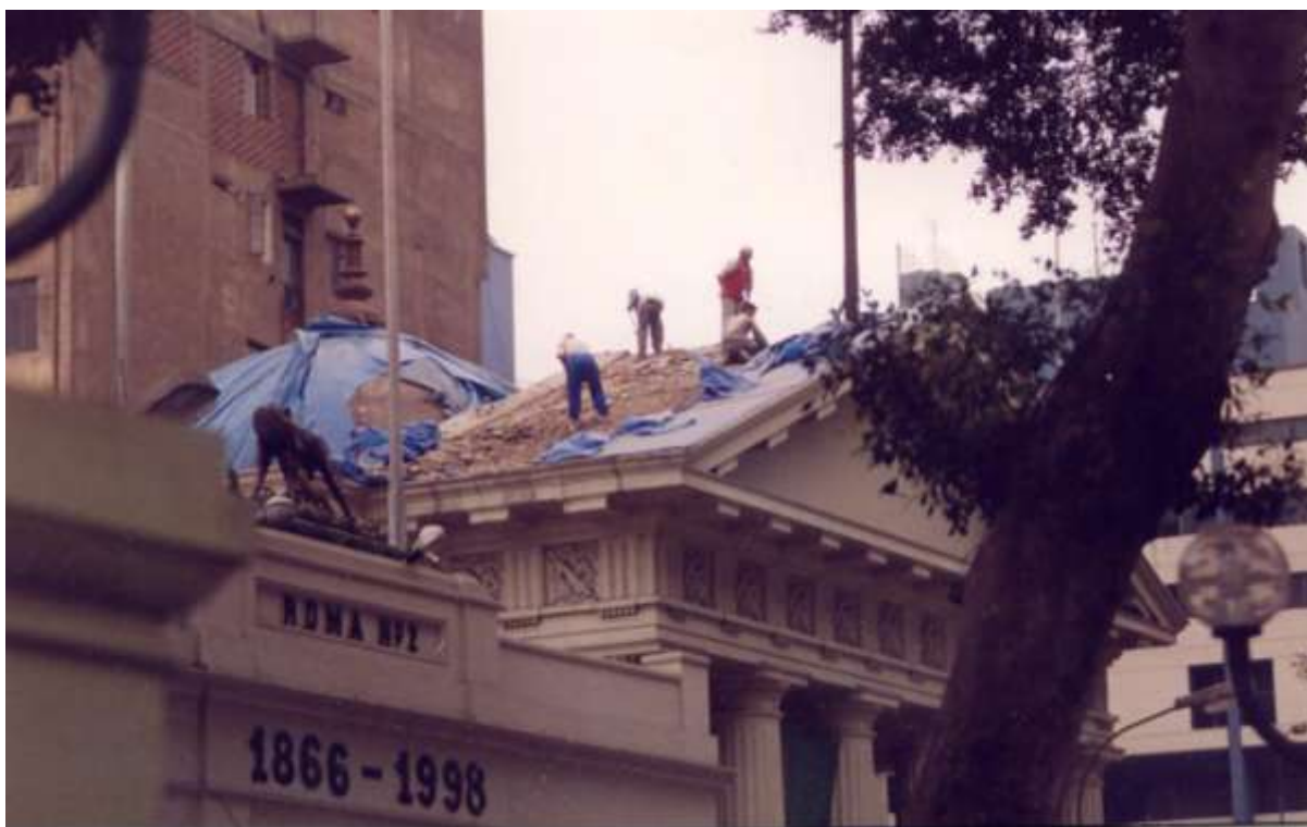
Trabajos de restauración del pórtico y la cúpula (1998)
