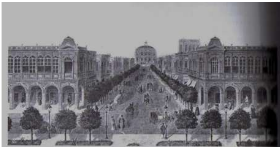
Fig. n° 8. Perspectiva de la Avenida 28 de Julio con el edificio del Congreso como remate. (Memoria de la Municipalidad de Lima, 1901)
