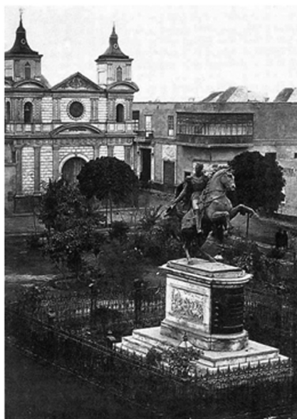
Monumento al libertador Simón Bolívar, Plaza Bolívar, Lima, Perú. Obsérvese la antigua Iglesia de Santa María de la Caridad, demolida para construir el Palacio Legislativo.
