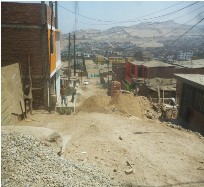
2154527. MEJORAMIENTO DE CALLES EN EL AA.HH. VIRGEN DE GUADALUPE, DISTRITO VENTANILLA
