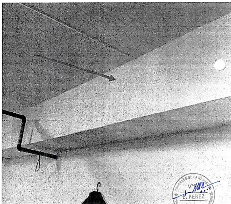
Fisuras en el techo y viga
