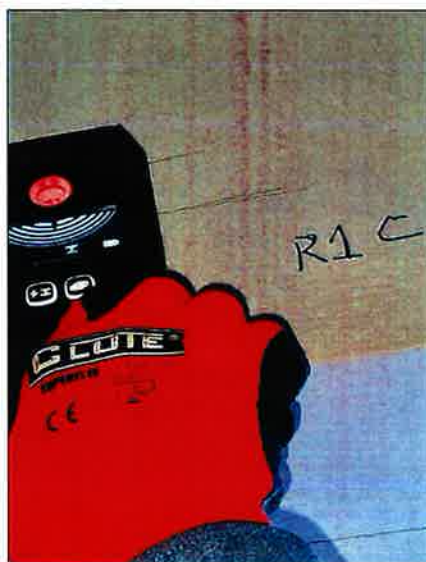
Vista de Escaneo Punto S3-R1C. Viga
