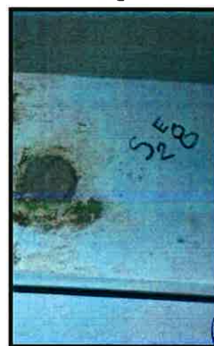
Foto N° 22: Reposición de Concreto en Viga
