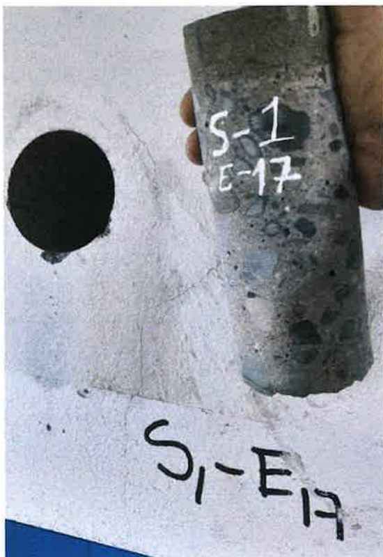
PERFORACIÓN EN VIGA S1 E17
