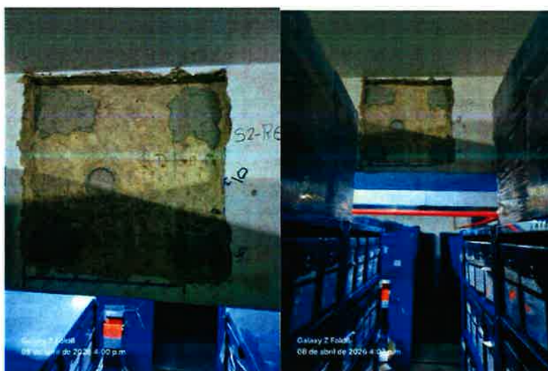
VIGA S2 – R6
