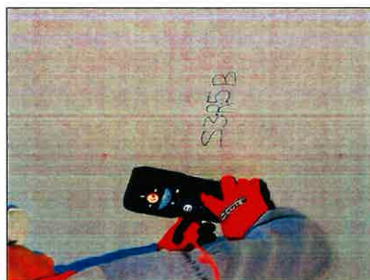
Vista de Escaneo Punto S3-R5B. Losa Techo
