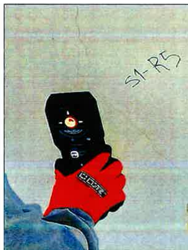
Vista de Escaneo Punto S1-R5. Losa Techo
