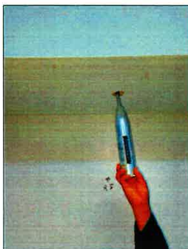
Vista de Esclerometría Punto S2-R5. Aplicación del esclerómetro
