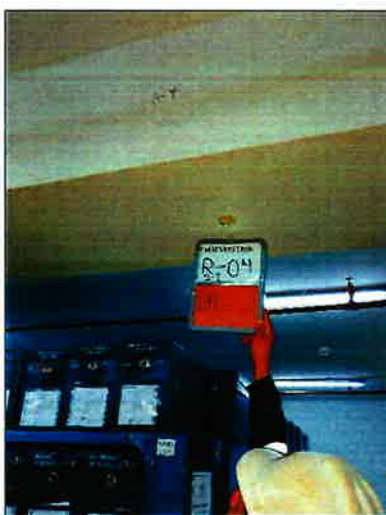
Vista de Esclerometría Punto S1-R4. Viga
