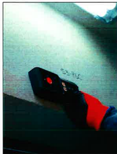
Vista de Escaneo Punto S3-R6C. Viga
