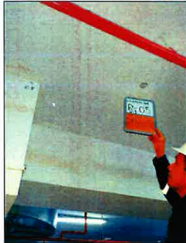
Vista de Esclerometría Punto S1-R5. Losa techo
