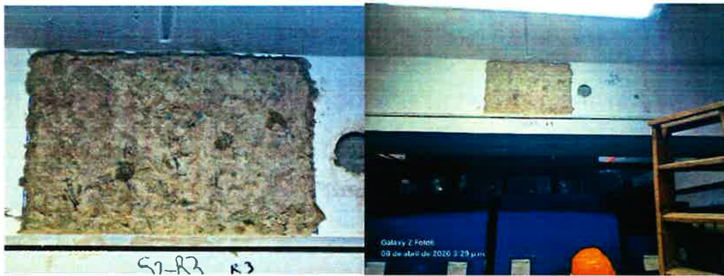
VIGA S2 – R3
