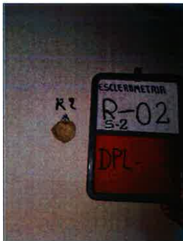
Vista de Esclerometría Punto S2-R2. Viga
