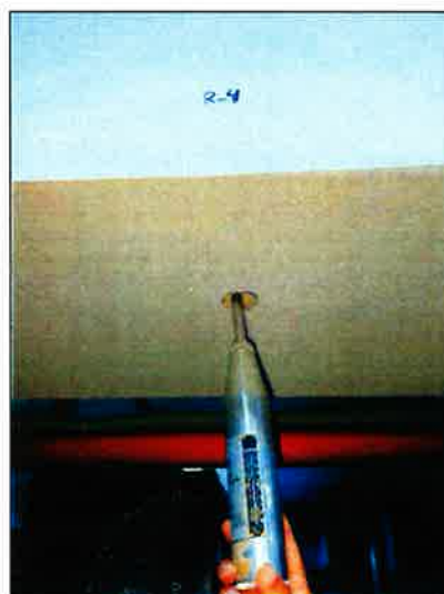
Vista de Esclerometría Punto S2-R4. Aplicación del esclerómetro
