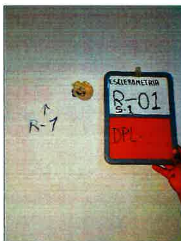
Vista de Esclerometría Punto S1-R1. Pared Placa
