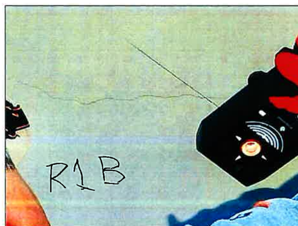
Vista de Escaneo Punto S3-R1B. Losa techo
