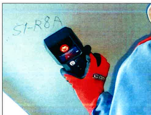
Vista de Escaneo Punto S1-R8. Losa techo
