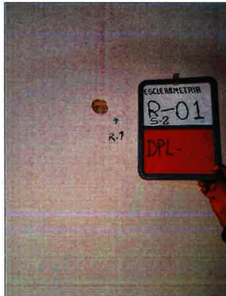
Vista de Esclerometría Punto S2-R1. Pared Placa
