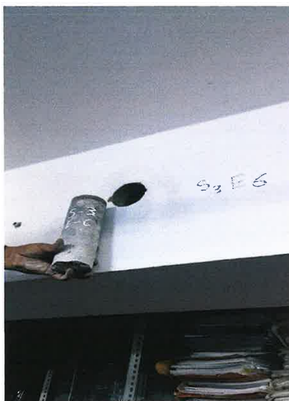
PERFORACIÓN DE VIGA S3 E6
