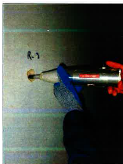
Vista de Esclerometría Punto S3-R3. Aplicación del esclerómetro
