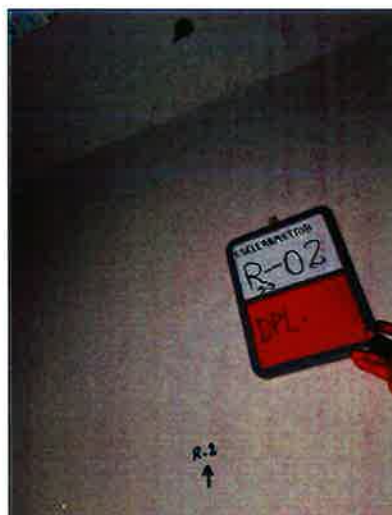
Vista de Esclerometría Punto S3-R2. Losa Techo
