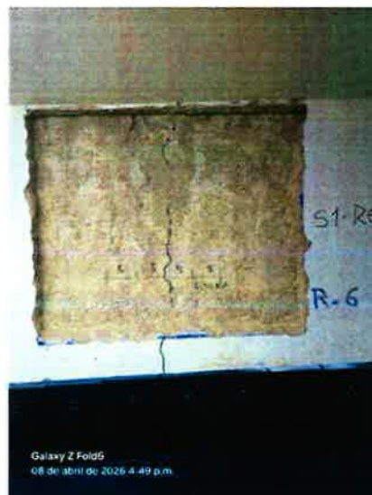
Foto 1. VIGA S1 – R6.
