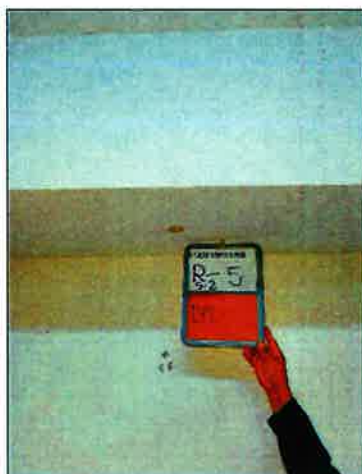
Vista de Esclerometría Punto S2-R5. Base Viga
