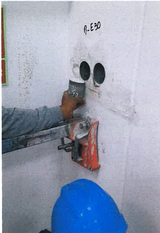
PERFORACIÓN EN COLUMNA P1 E30
