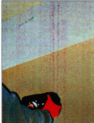
Vista de Escaneo Punto S1-R3B. Viga
