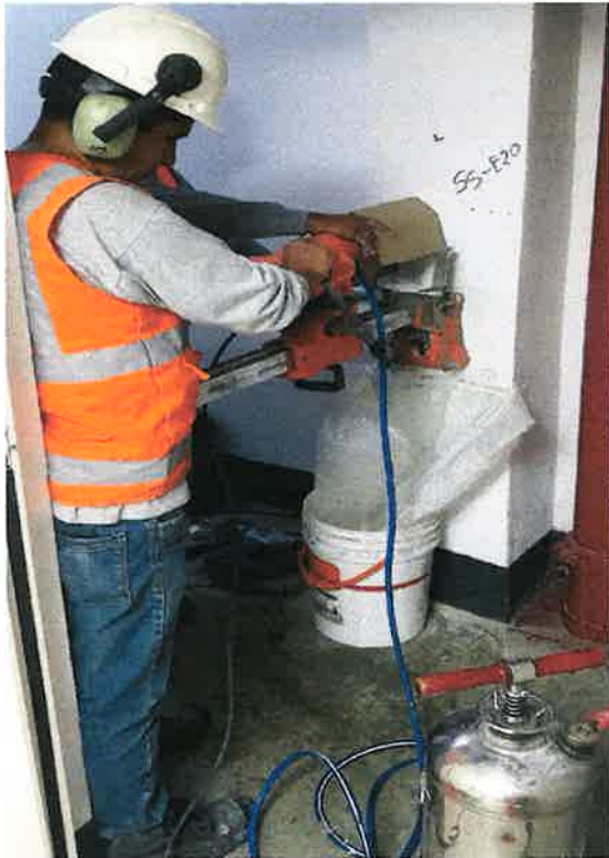
PERFORACIÓN EN COLUMNA SS E20
