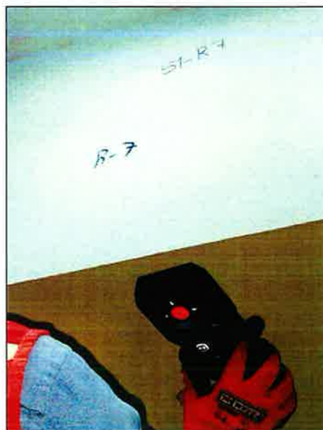
Vista de Escaneo Punto S1-R7. Viga
