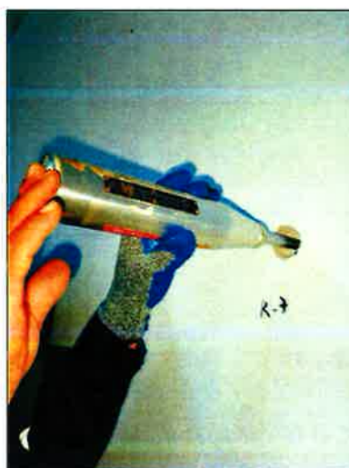
Vista de Esclerometría Punto S3-R7. Aplicación del esclerómetro
