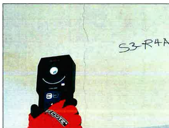
Vista de Escaneo Punto S3-R4A. Viga
