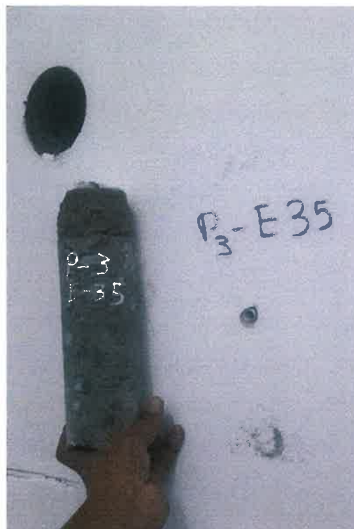
PERFORACIÓN EN VIGA P3 E35
