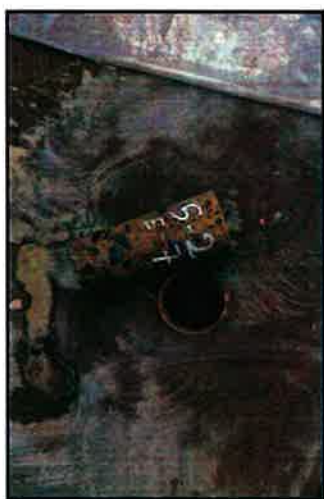
Foto N° 17: Extracción de Concreto Endurecido del Sótano 2 – Extracción 07
