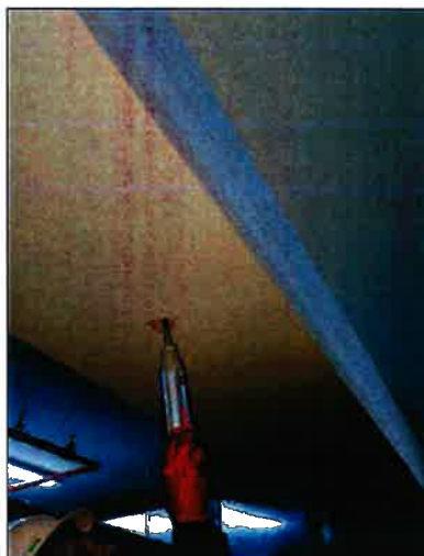
Vista de Esclerometría Punto S1-R3. Aplicación del esclerómetro
