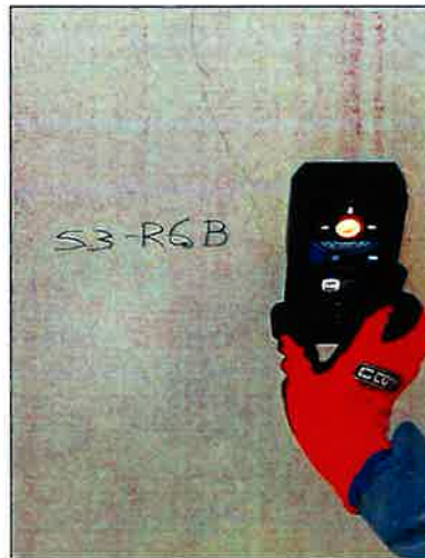
Vista de Escaneo Punto S3-R6B. Losa Techo
