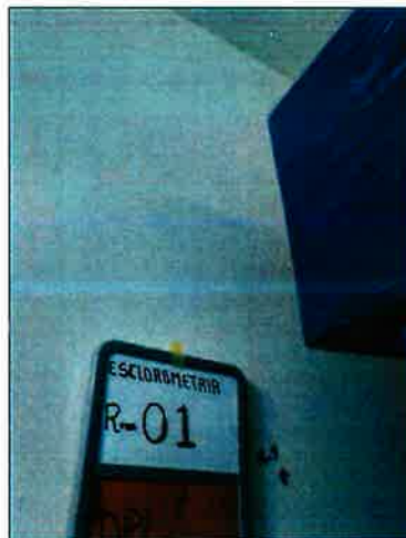
Vista de Esclerometría Punto S3-R1. Pared Placa
