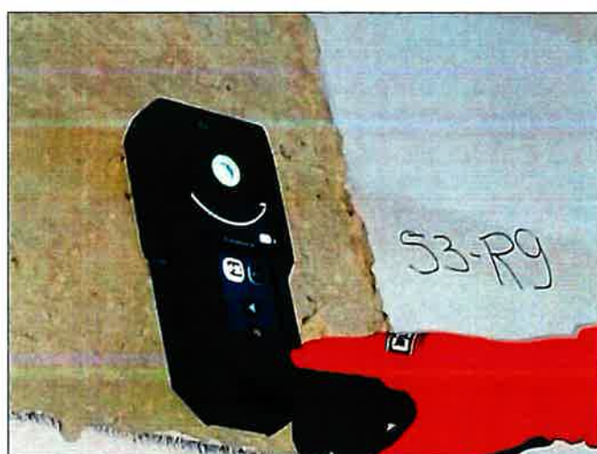
Vista de Escaneo Punto S3-R9. Viga
