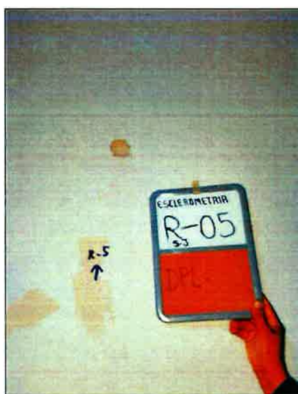
Vista de Esclerometría Punto S3-R5. Pared Placa
