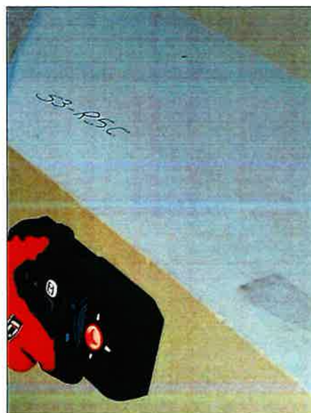
Vista de Escaneo Punto S3-R5C. Viga
