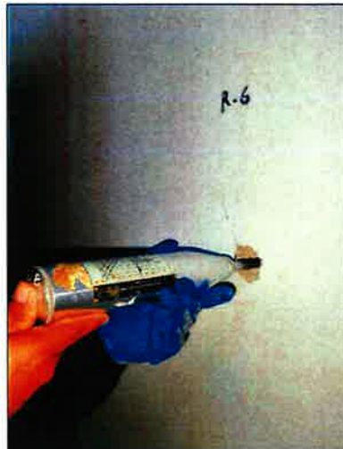
Vista de Esclerometría Punto S3-R6. Aplicación del esclerómetro
