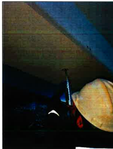
Vista de Esclerometría Punto S1-R2. Aplicación del esclerómetro
