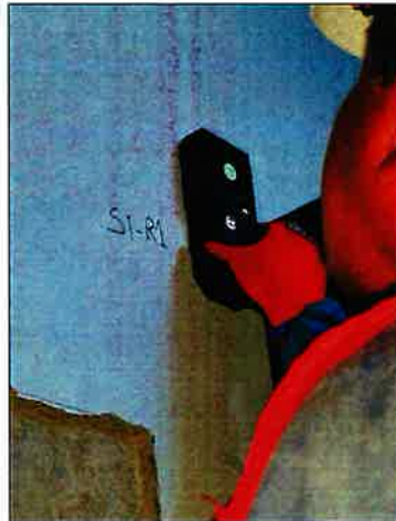
Vista de Escaneo Punto S1-R1. Pared Placa
