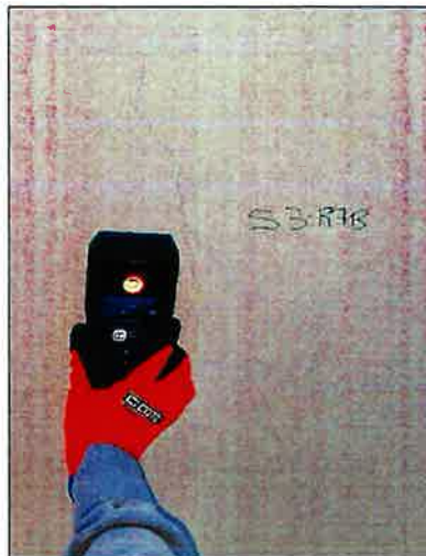
Vista de Escaneo Punto S3-R7B. Pared Placa
