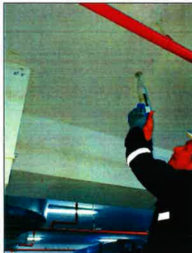
Vista de Esclerometría Punto S1-R5. Aplicación del esclerómetro
