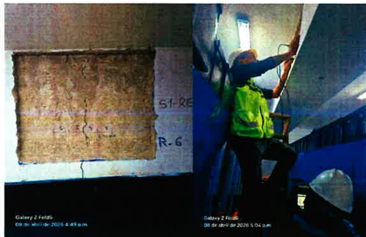
VIGA S1 – R6
