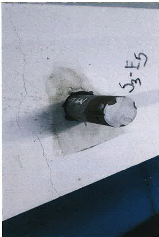
PERFORACIÓN EN VIGA S3 E5
