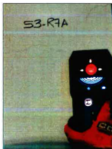
Vista de Escaneo Punto S3-R7A. Pared Placa
