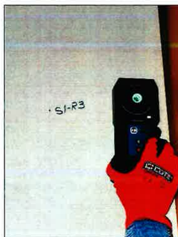
Vista de Escaneo Punto S1-R3. Pared Placa
