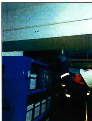
Vista de Esclerometría Punto S2-R6. Aplicación del esclerómetro
