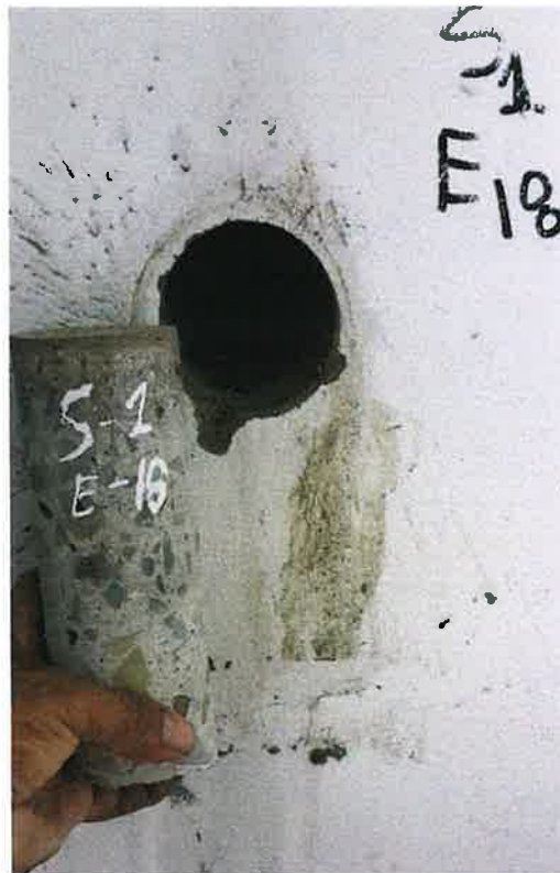
PERFORACIÓN EN VIGA S1 E18
