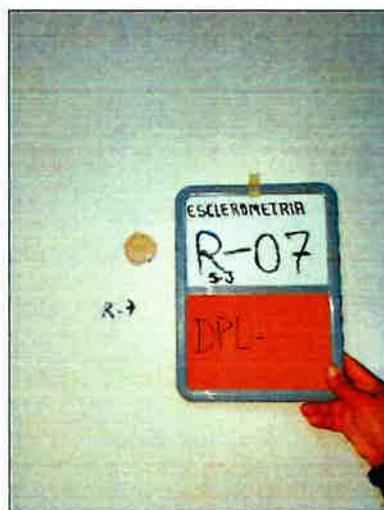
Vista de Esclerometría Punto S3-R7. Pared Placa
