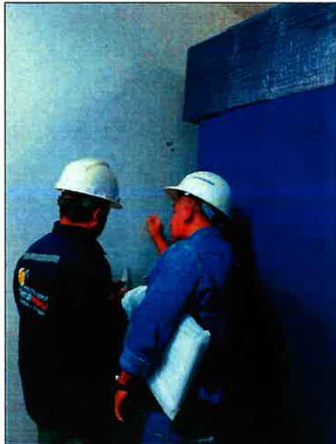
Vista de Esclerometría Punto S3-R1. Pared Placa
