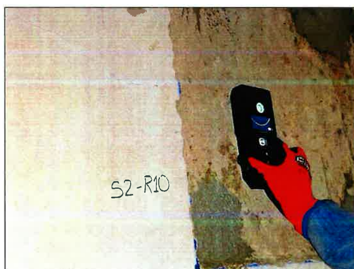
Vista de Escaneo Punto S2-R10. Pared Placa
