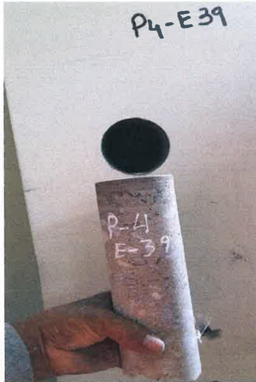
PERFORACIÓN EN COLUMNA P4 E39
