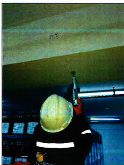
Vista de Esclerometría Punto S1-R4. Aplicación del esclerómetro
