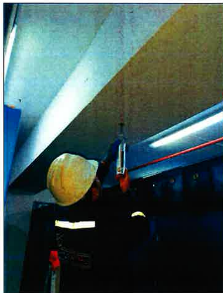
Vista de Esclerometría Punto S1-R6. Aplicación del esclerómetro
