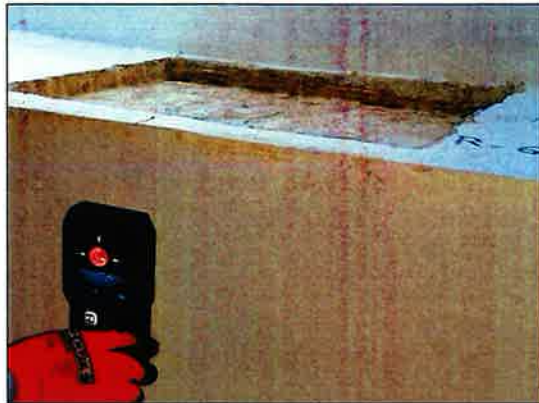
Vista de Escaneo Punto S1-R6. Viga
