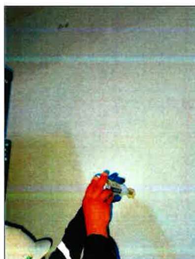
Vista de Esclerometría Punto S1-R8. Aplicación del esclerómetro
