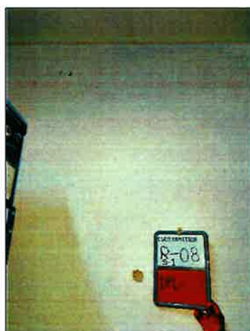
Vista de Esclerometría Punto S1-R8. Pared Placa
