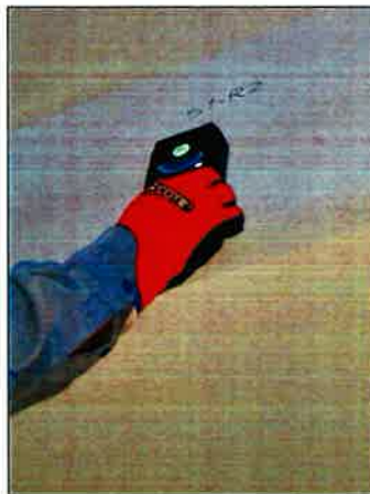
Vista de Escaneo Punto S1-R2. Viga
