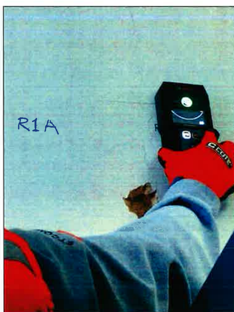
Vista de Escaneo Punto S3-R1A. Pared Placa
