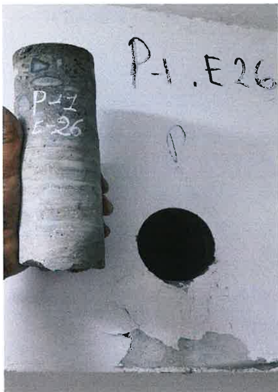
PERFORACIÓN EN VIGA P1 E26
