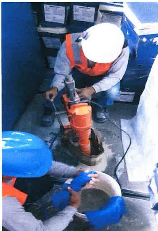
PERFORACIÓN EN LOSA MACISA S2 E7
