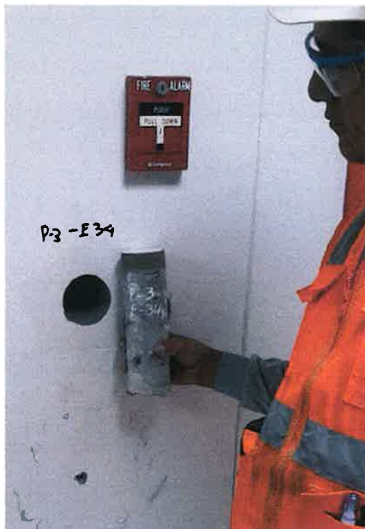
PERFORACIÓN EN COLUMNA P3 E34
