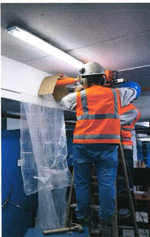
PERFORACIÓN EN LOSA MACISA S2 E7
