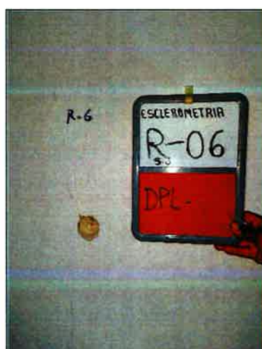
Vista de Esclerometría Punto S3-R6. Pared Placa
