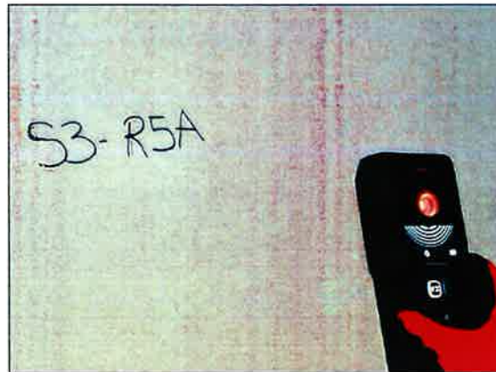
Vista de Escaneo Punto S3-R5A. Pared Placa
