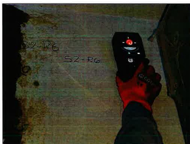
Vista de Escaneo Punto S2-R6. Pared Placa
