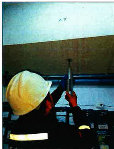
Vista de Esclerometría Punto S1-R7. Aplicación del esclerómetro
