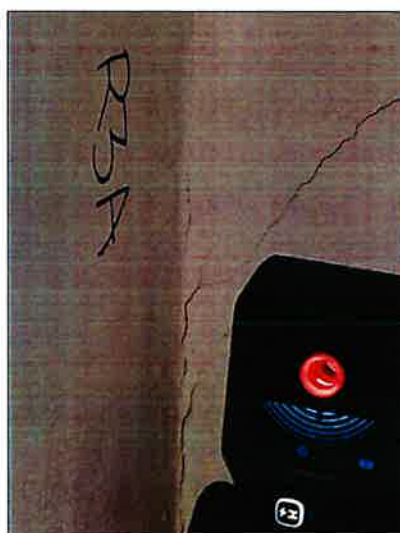
Vista de Escaneo Punto S3-R3A. Columna
