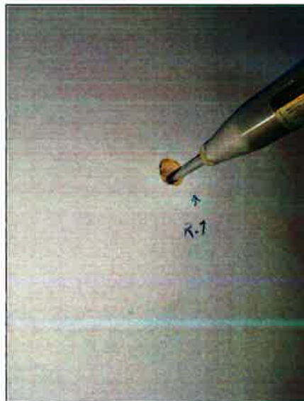
Vista de Esclerometría Punto S2-R1. Aplicación del esclerómetro
