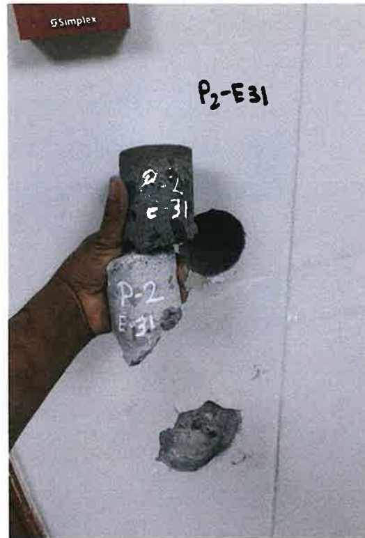
PERFORACIÓN EN COLUMNA P2 E31
