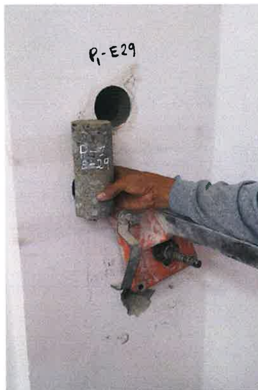
PERFORACIÓN EN COLUMNA P1 E29
