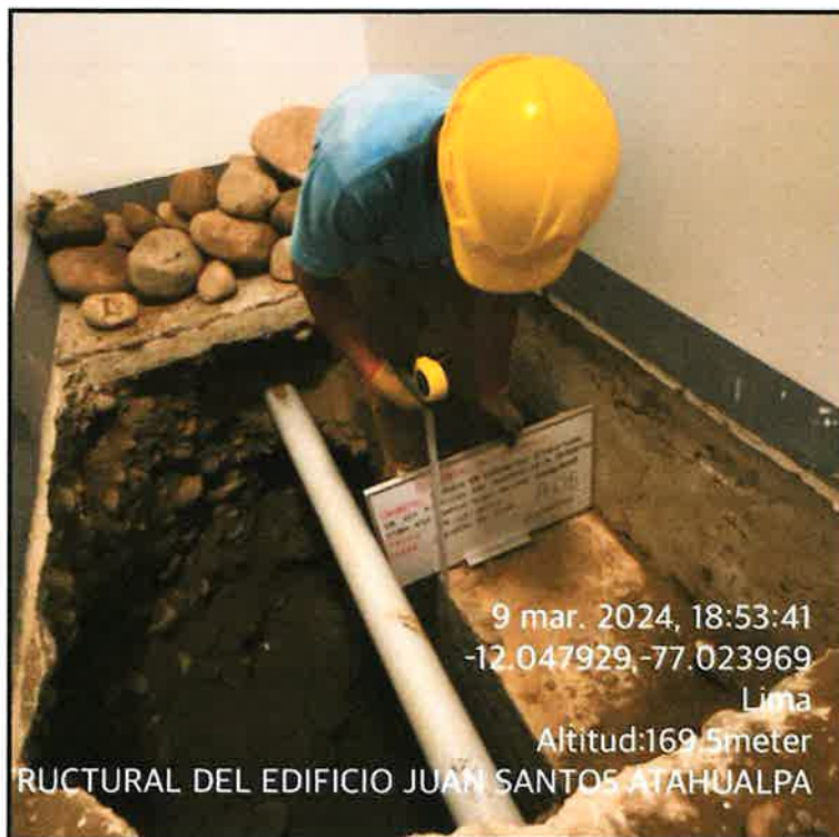
Ilustración 23: La imagen muestra el proceso de excavación y auscultación de la zapata A-05. Se observa que durante la excavación se ha encontrado una tubería de instalaciones, lo que ha llevado a tomar medidas de seguridad y prevención adecuadas para el personal
