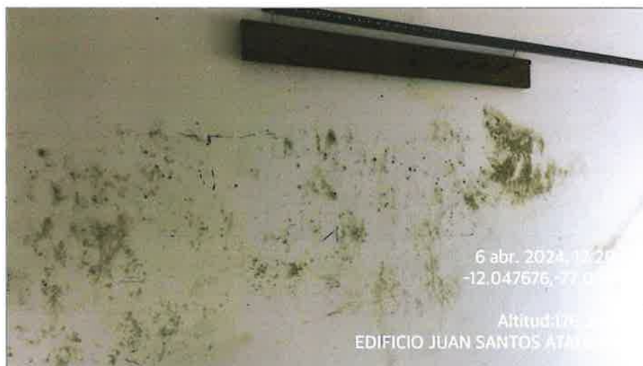
Figura 6: Bloque "B" – Presencia de humedad en muros no estructurales de tabiquería.
