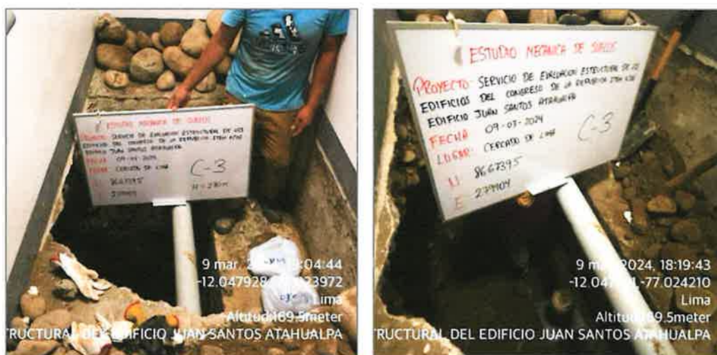
Figura 9: Sondaje de campo y ensayo de densidad de campo – Calicata C-03.
