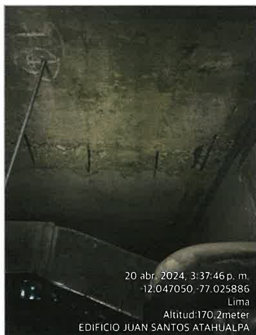
Figura 8: Bloque "A" – Presencia de corrosión en el acero de refuerzo e identificación de cangrejerías en elementos estructurales predominantes situados sobre el falso cielo raso.
