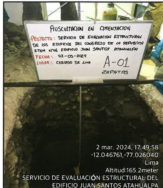
Ilustración 15: La auscultación de las zapatas A-01 en la edificación es un proceso crucial para evaluar la estructura y el tipo de material de sustrato de relleno utilizado
