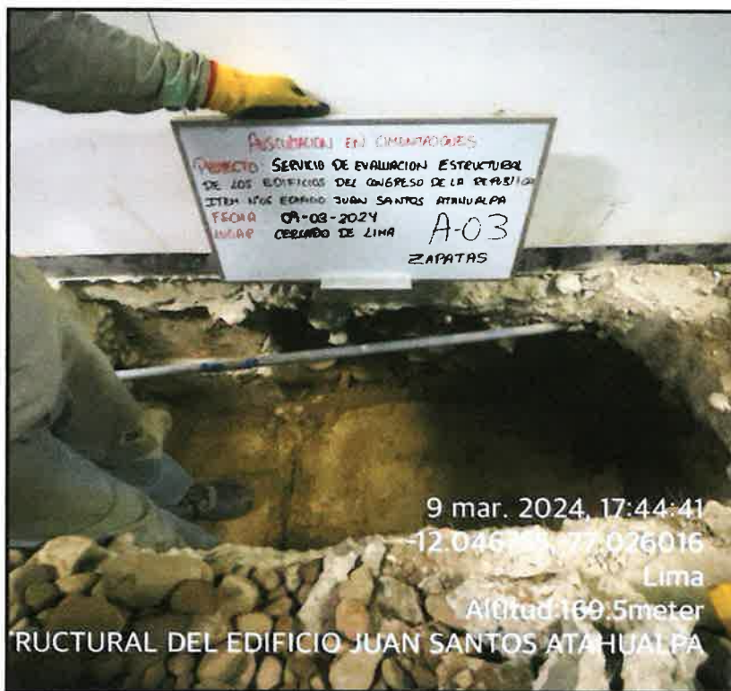
Ilustración 19: La imagen muestra la auscultación de la zapata A-03, donde se evidencia un cuidado meticuloso para no afectar las tuberías de instalaciones durante la excavación
