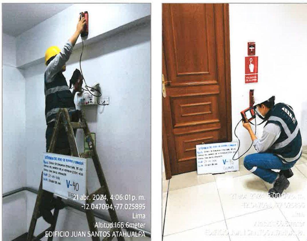
Figura 11: Verificación de corrosión e identificación de acero de refuerzo en elementos estructurales predominantes horizontales y verticales.
