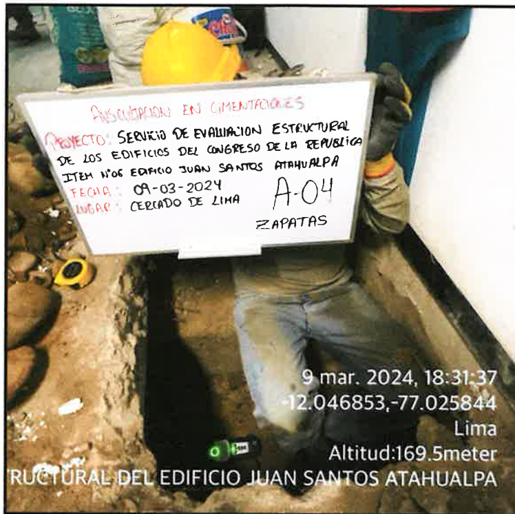
Ilustración 21: La imagen muestra el proceso de auscultación de la zapata A-04, con nuestro personal oficial sentado sobre la estructura analizada. Esto sugiere una evaluación detallada y minuciosa de la zapata, con el personal involucrado directamente en la inspección para garantizar la precisión y la exhaustividad del proceso.
