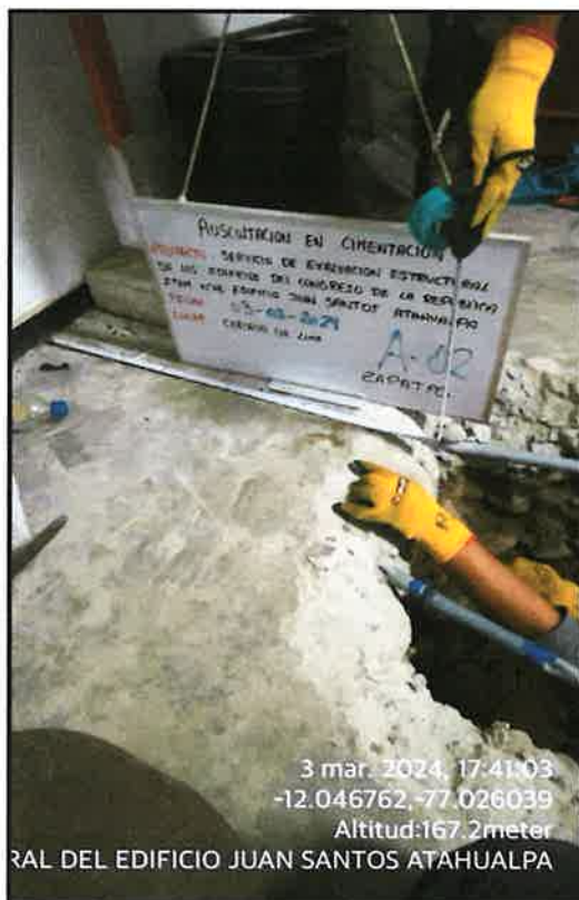
Ilustración 18: La imagen muestra el proceso de medición y replanteo de medidas de la zapata A-02.
