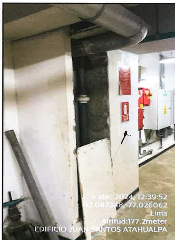
Ilustración 8: Se identifica en la imagen que hay tuberías expuestas en los ductos, lo cual indica que deberían estar cubiertas de manera segura
