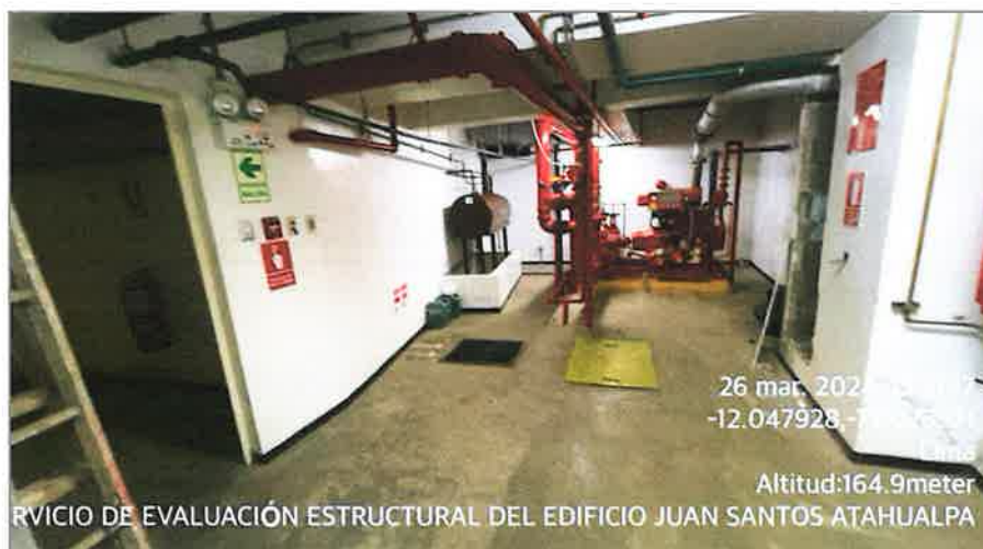
Figura 5: Bloque "B" – Área destinada a vestuarios de personal administrativo y/o cuarto de máquinas.
