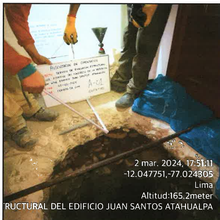
Ilustración 16: La verificación de las mediciones de la zapata auscultada A-01 es un paso crucial en el proceso de evaluación estructural. Esto implica asegurarse de que las dimensiones de la zapata, como la longitud, el ancho y la profundidad, estén en conformidad con las especificaciones del diseño estructural
