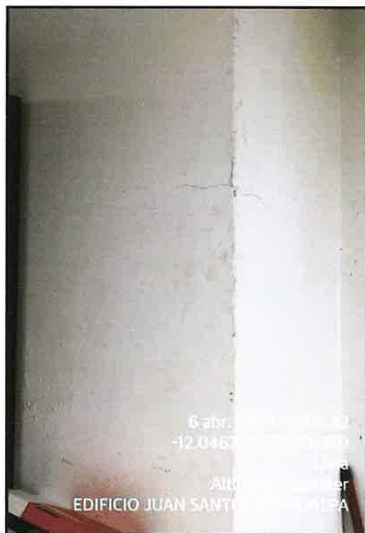
Ilustración 6: Se evidencian pequeñas grietas superficiales con dirección horizontal en la parte media de la columna visualizada
