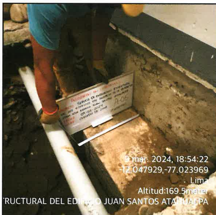
Ilustración 24: Proceso de medición y verificación de dimensiones de zapata auscultada A-05
