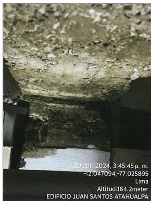
Figura 8: Bloque "A" – Presencia de corrosión en el acero de refuerzo e identificación de cangrejerías en elementos estructurales predominantes situados sobre el falso cielo raso.
