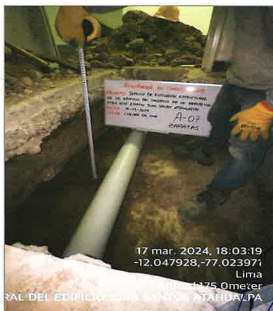
Figura 10: Auscultaciones de la cimentación del Edificio Juan Santos Atahualpa.
