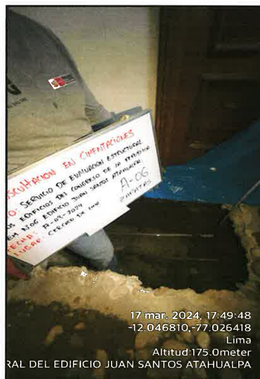
Ilustración 26: Medición y replanteo de dimensiones de zapata auscultada A-06
