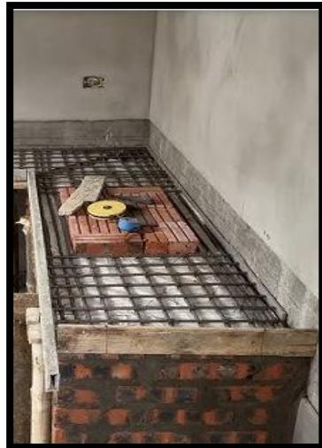
Imagen referencial de mesada de concreto en construcción y con acabado final.
