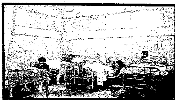
HOSPITAL DESPUES DEL TERREMOTO
