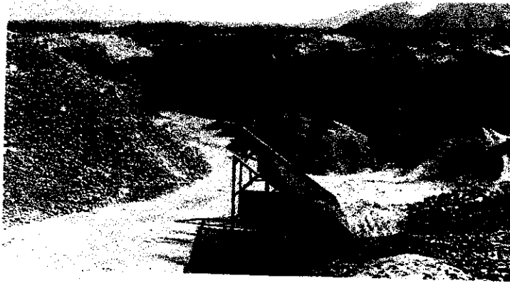
FOTO.- Se observa una zaranda donde se está realizando la operación de extracción y se puede observar lo inestable de sus taludes de operación , esto constituye un peligro inminente.
