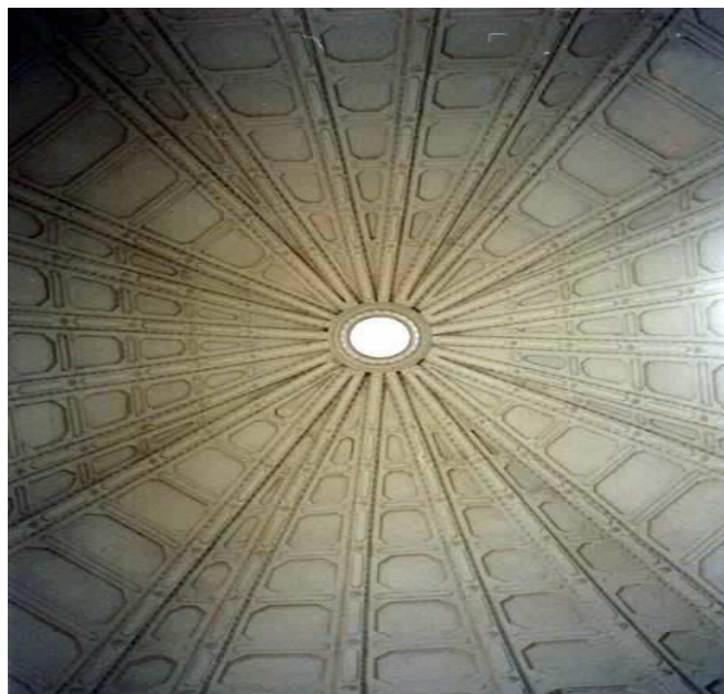
Vista interior de la cúpula
