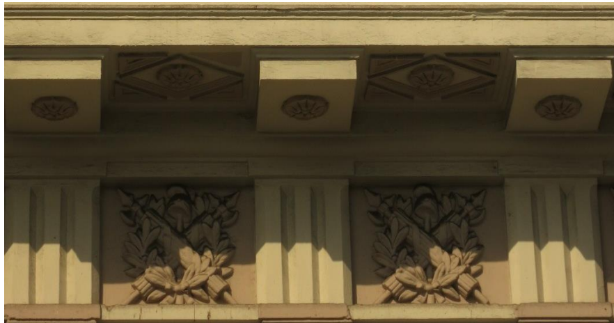
Detalle del friso de la fachada
