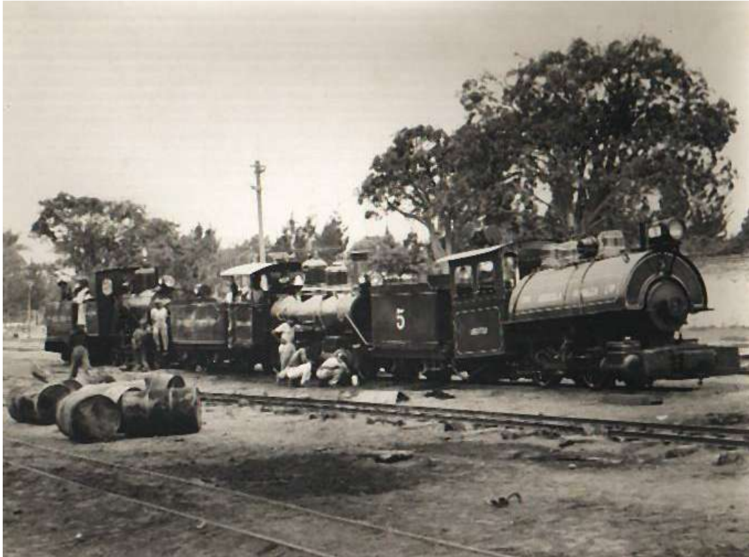
Locomotora de la Hacienda Pomalca (1960) 2
