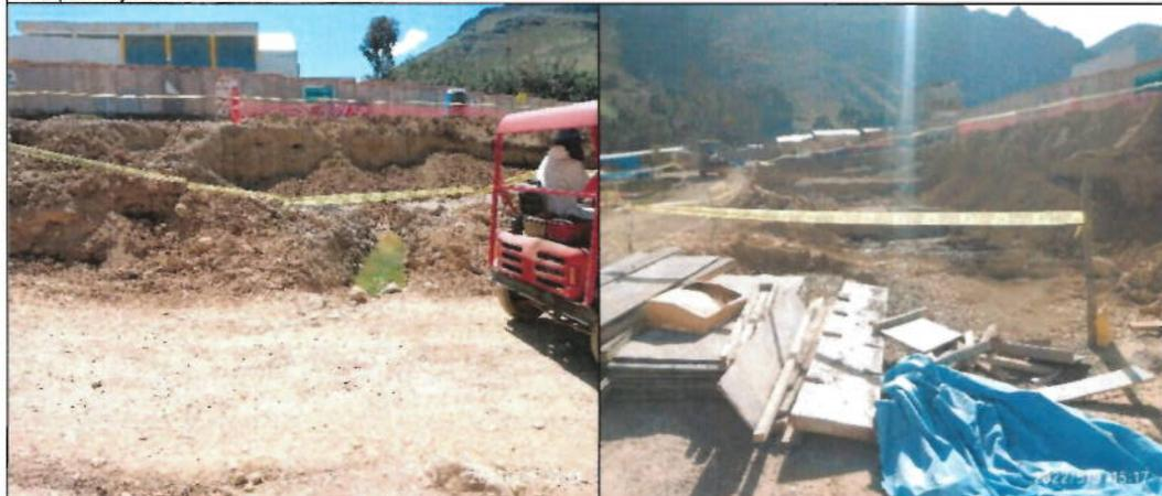
**Fotografías n.º 5 y 6:** En los terrenos donde se construirán los Bloques "A", "B" y "C", se evidenció la ejecución de movimiento de tierras (excavación, corte y nivelación), advirtiéndose que dichas zonas se encuentran saturadas e inundadas por fuentes naturales de aguas subterráneas, cuya fuente de agua se encuentra ubicada aproximadamente entre el Bloque "B" y "C".
