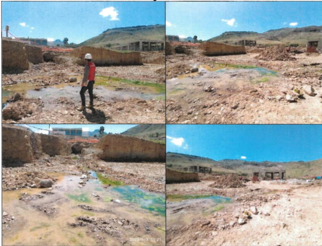
**Fotografías n.º 1, 2, 3 y 4:** En los terrenos donde se construirán los Bloques "1", "2", "3", "4", "5", "6" y "7", se evidenció la ejecución de partidas de movimiento de tierras (excavación, corte y nivelación), en la cual se advierte que dichas zonas se encuentran saturadas e inundadas por fuentes de agua subterráneas, cuya fuente de agua se encuentra ubicada aproximadamente entre el Bloque "1" y "4".
