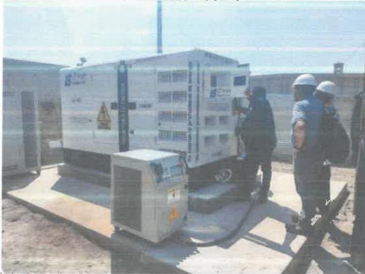
Foto 4; Entrega, instalación y prueba de resistencia de grupo electrógeno.
