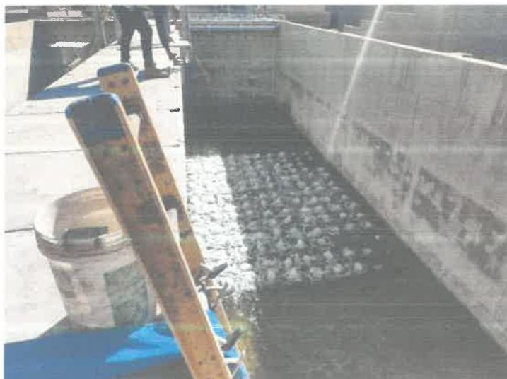
Foto 3; Prueba hidráulica de los equipos de difusores de burbujas.
