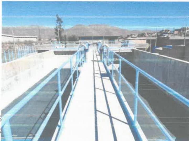
Foto 6; Construcción y colocación de barandas del tanque reactor biológico.
