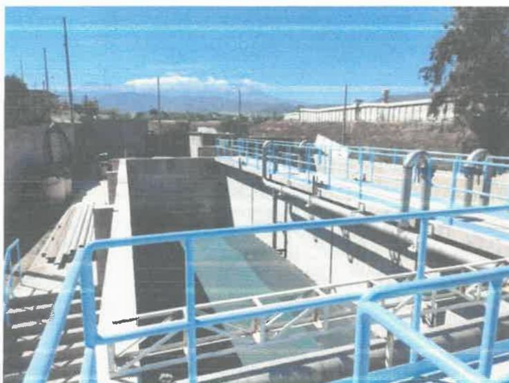
Foto 7; Construcción y colocación de barandas del tanque reactor biológico.
