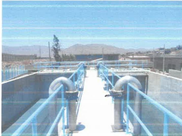
Foto 13: Instalación y montaje de línea de ACERO INOX, que suministra oxígeno al tanque REACTOR BIOLÓGICO.
