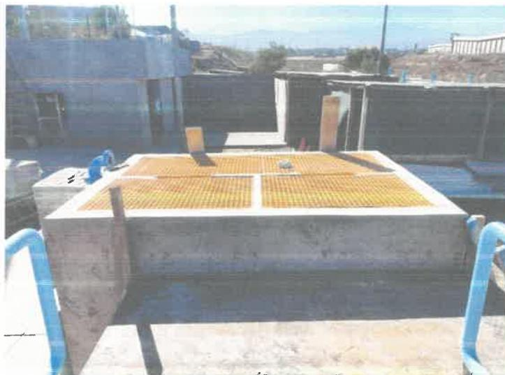
Foto 14: Instalación rejillas y perfiles reforzadas de fibra de vidrio en cámara de distribución.
