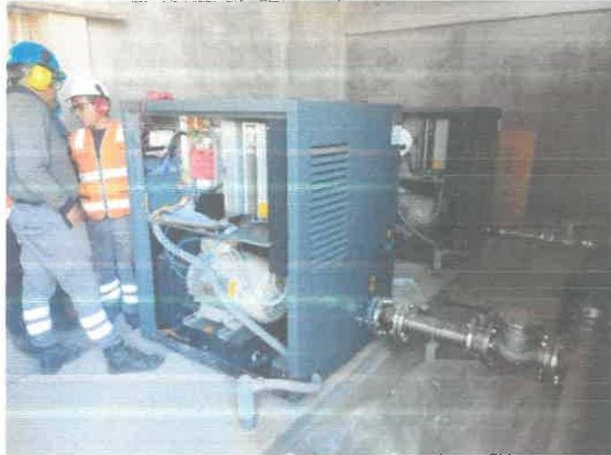
Foto 1; Entrega e instalación de equipos de soplador trilobular.
