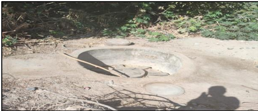
Fotografía 14: Biodigestores en el centro poblado de La Mezana
