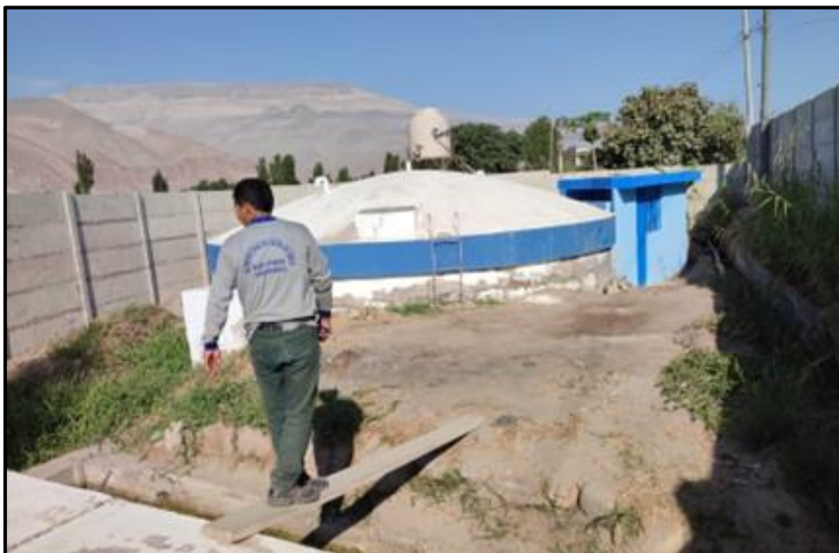
Fotografía 3: Reservorio semienterrado de 165 m3.
