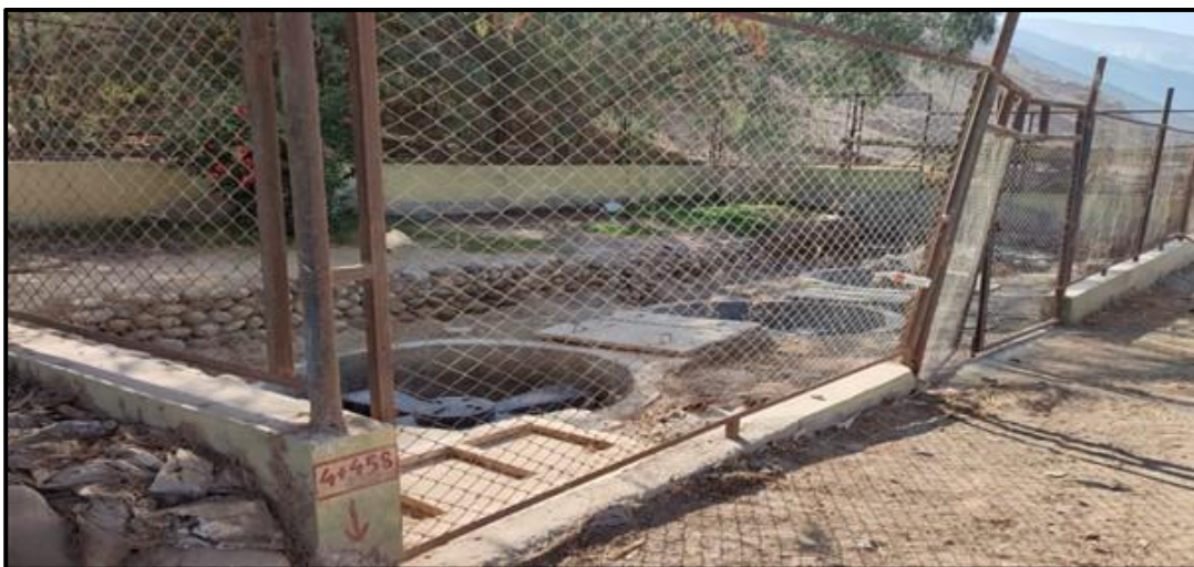
Fotografía 14: Biodigestores en el centro poblado de La Mezana
