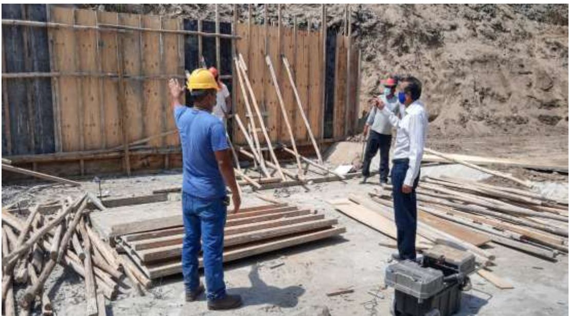
Supervisión de la obra de infraestructura de retención y captación de riego en el sector "Tortolitas"
