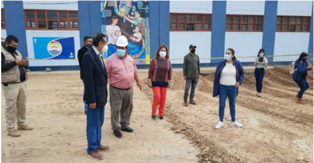
Supervisión a la obra de la I.E. N° 10017 en Santa Rosa
