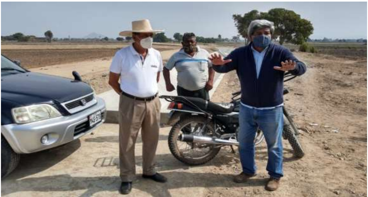
Supervisión de la obra del Canal Zanjón.
