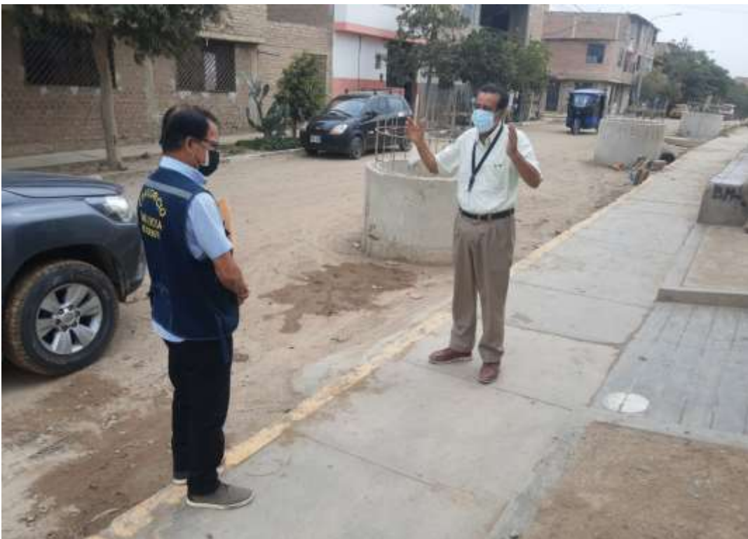
Supervisión de avance de obra del Servicio de Agua Potable y Alcantarillado en la Calles del Pueblo Joven Santa Rosa
