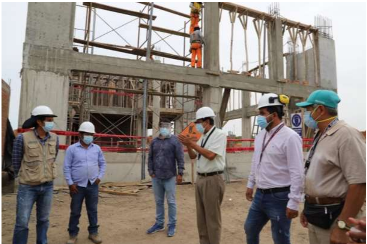
Recorrido por la construcción de la Institución Educativa de Nivel Inicial N° 474 del sector La Tina
