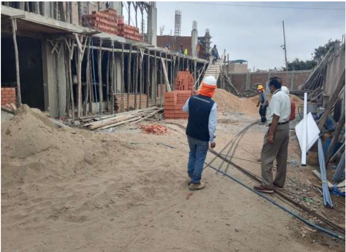
Supervisión de avance de obra del Servicio de Educación Inicial en la I.E N°474- La Tina
