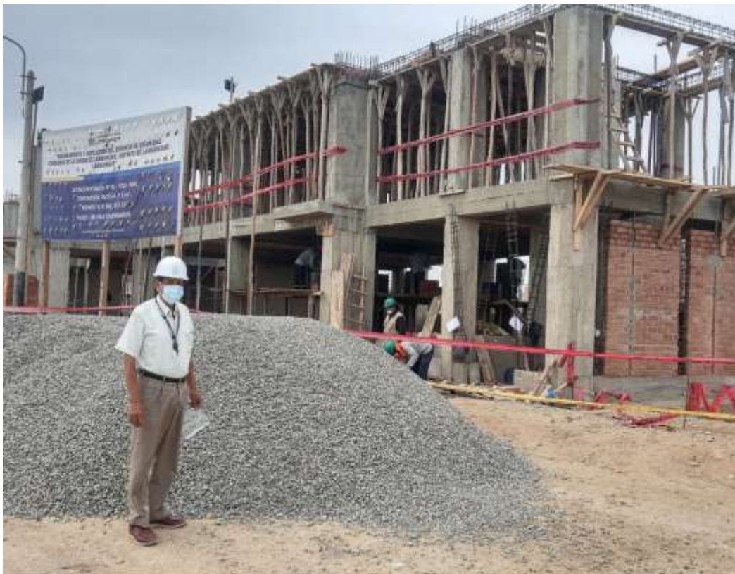
Supervisión de avance de obra del Servicio de seguridad ciudadana
