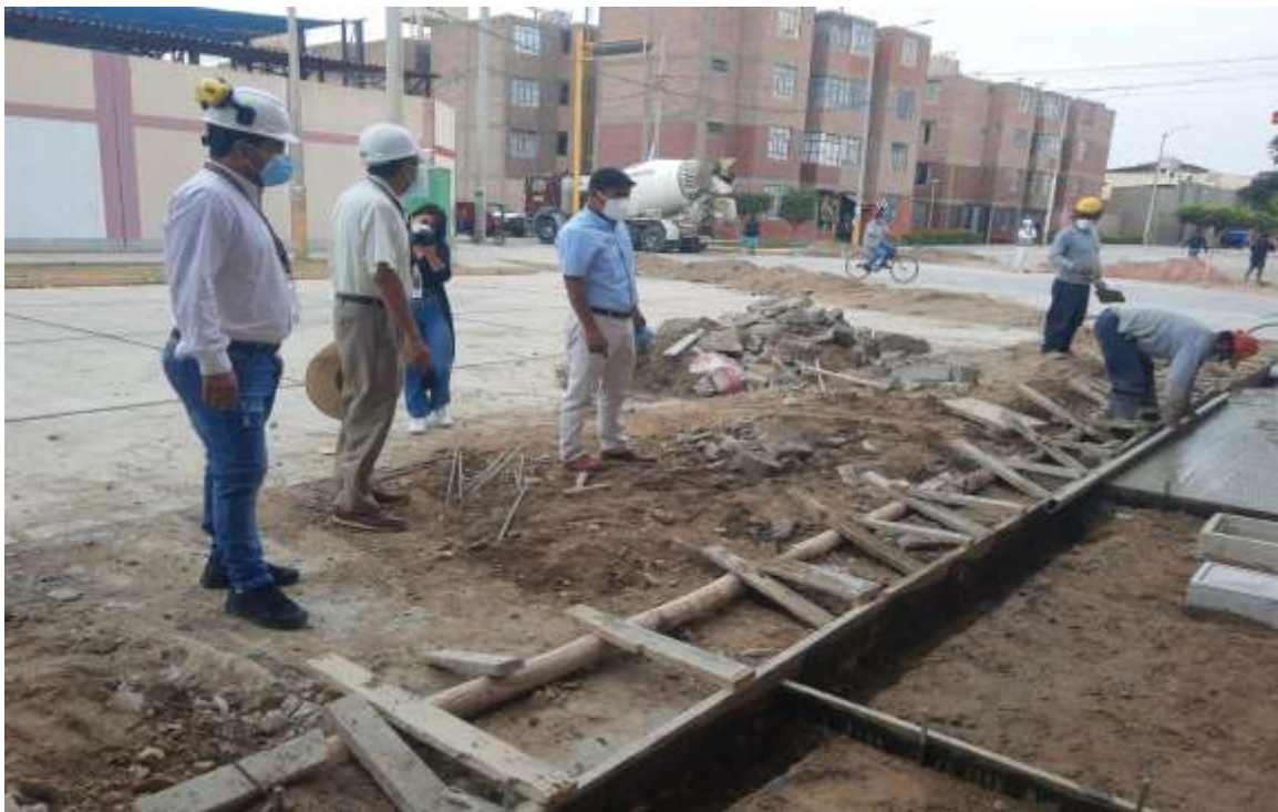
Supervisión de avance de obra de pistas y veredas en la Av. Huamachuco
