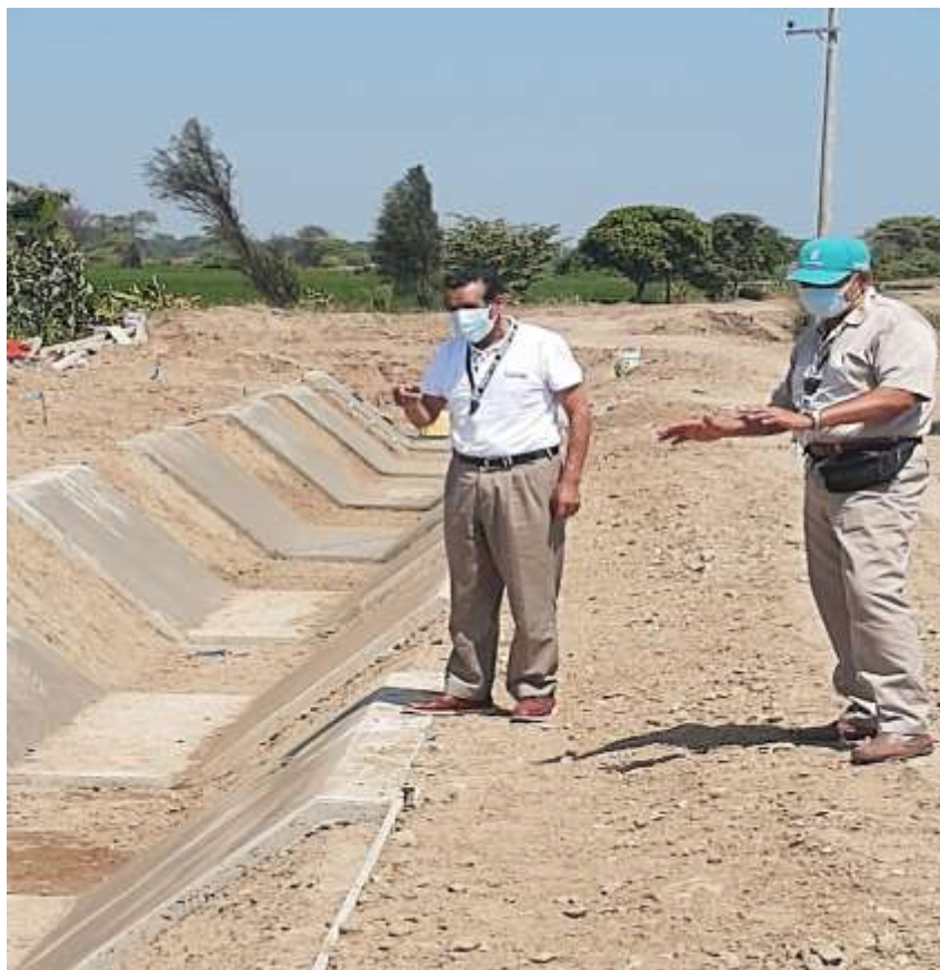
Recorrido por obra El Zanjón
