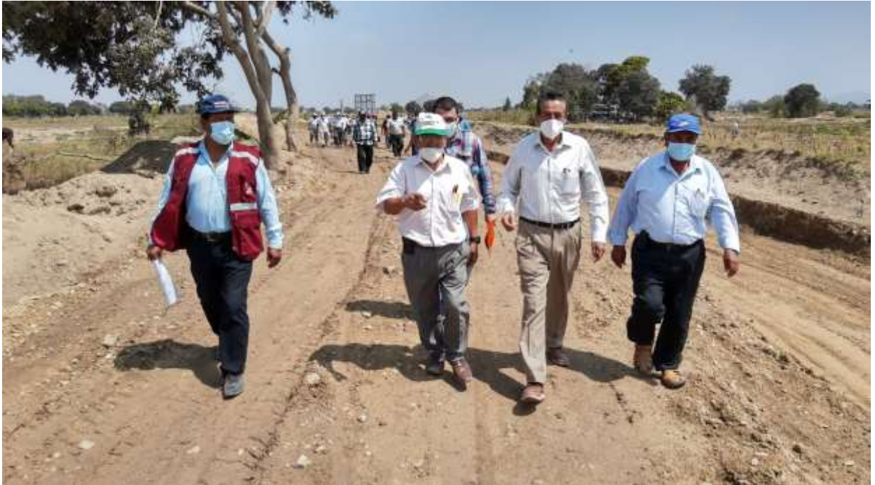
Supervisión y recorrido por el Canal Zanjón ubicado en el distrito de Mochumi
