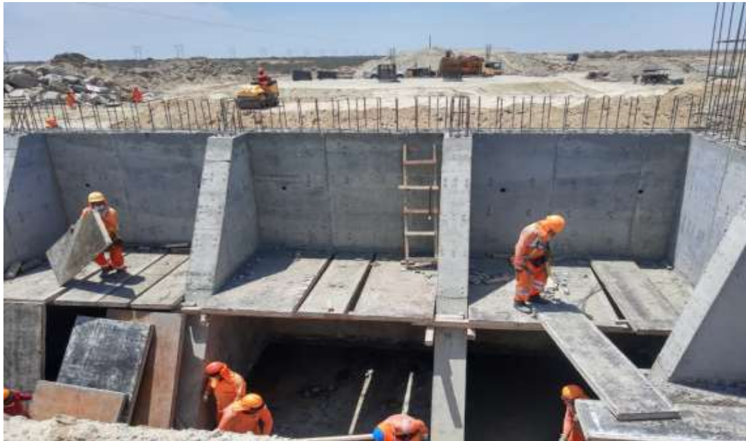
Supervisión de avance de obra.
