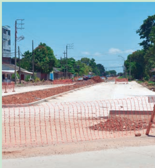
Construcción de la Av. Miraflores y Jirón J.F.Kenedy.
