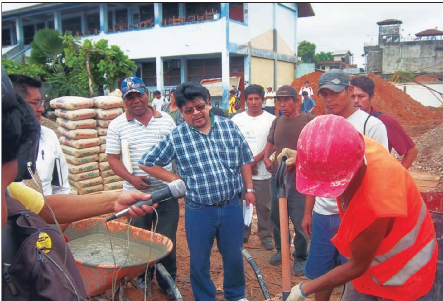
Visita de inspección a la obra de mejoramiento de la I.E. Jorge Chávez en Coronel Portillo, para verificar el cumplimiento de normas laborales de la empresa con los trabajadores.
