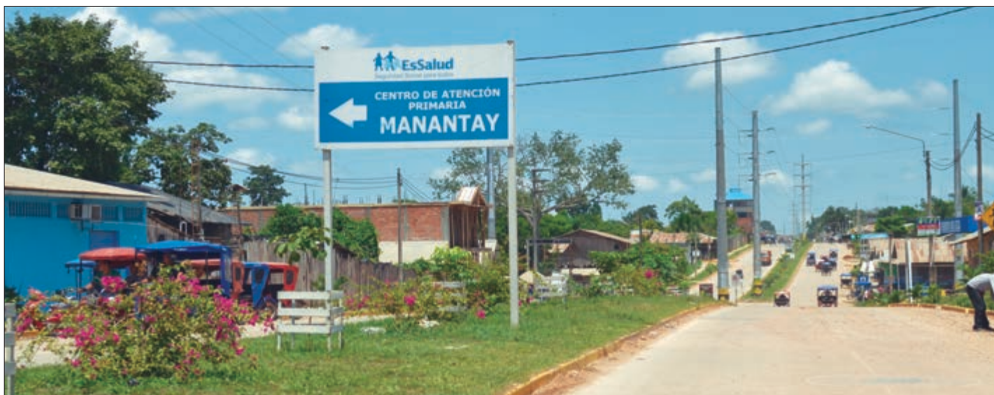
Pavimentación de la Avenida Aviación ( Avenida Centenario - Vía de Evitamiento)
