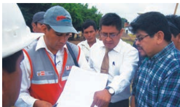
Seguimiento al cumplimiento de normas laborales con los trabajadores, en la obra de mejoramiento de la I.E. Jorge Chávez, con la participación del inspector de SUNAFIL.
