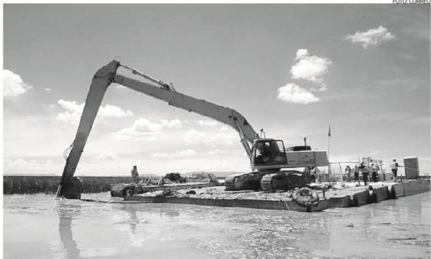
La excavadora se encuentra encima de la plataforma metálica flotante
