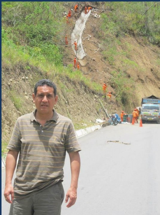
Supervisión del asfaltado del tramo San Ignacio - La Balsa. Al fondo se aprecian los avances de los trabajos de arte.
