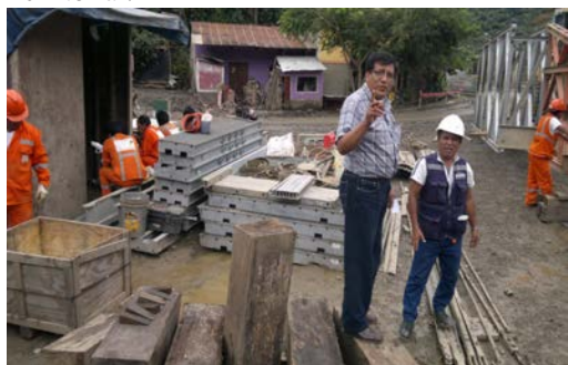
Inspección del Puente sobre el río Chinche – Maranura.
