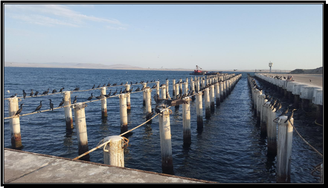
DAÑOS EN EL TERMINAL PORTUARIO POR EL TERREMOTO DE PISCO DEL 2007
