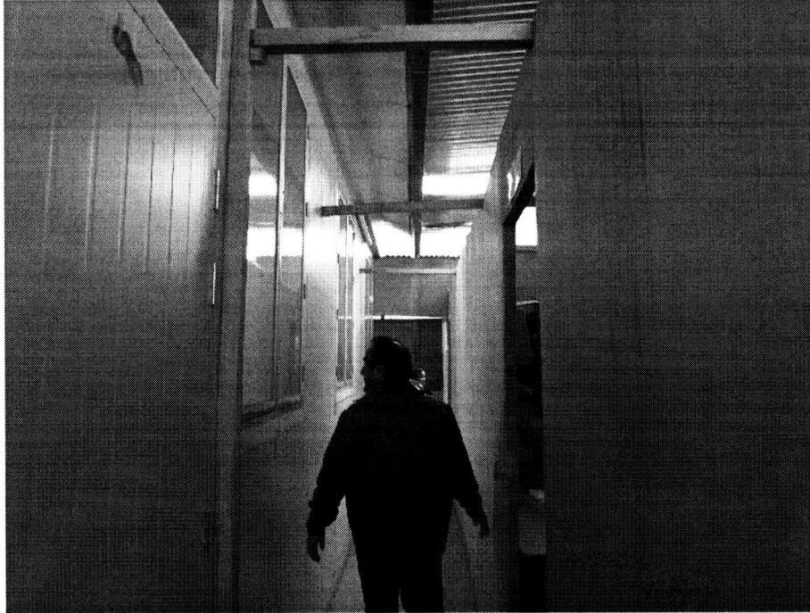
Imagen N° 09: Se puede observar que la Dirección de Estudios de la Institución es de triplay tanto en exteriores e interiores.
