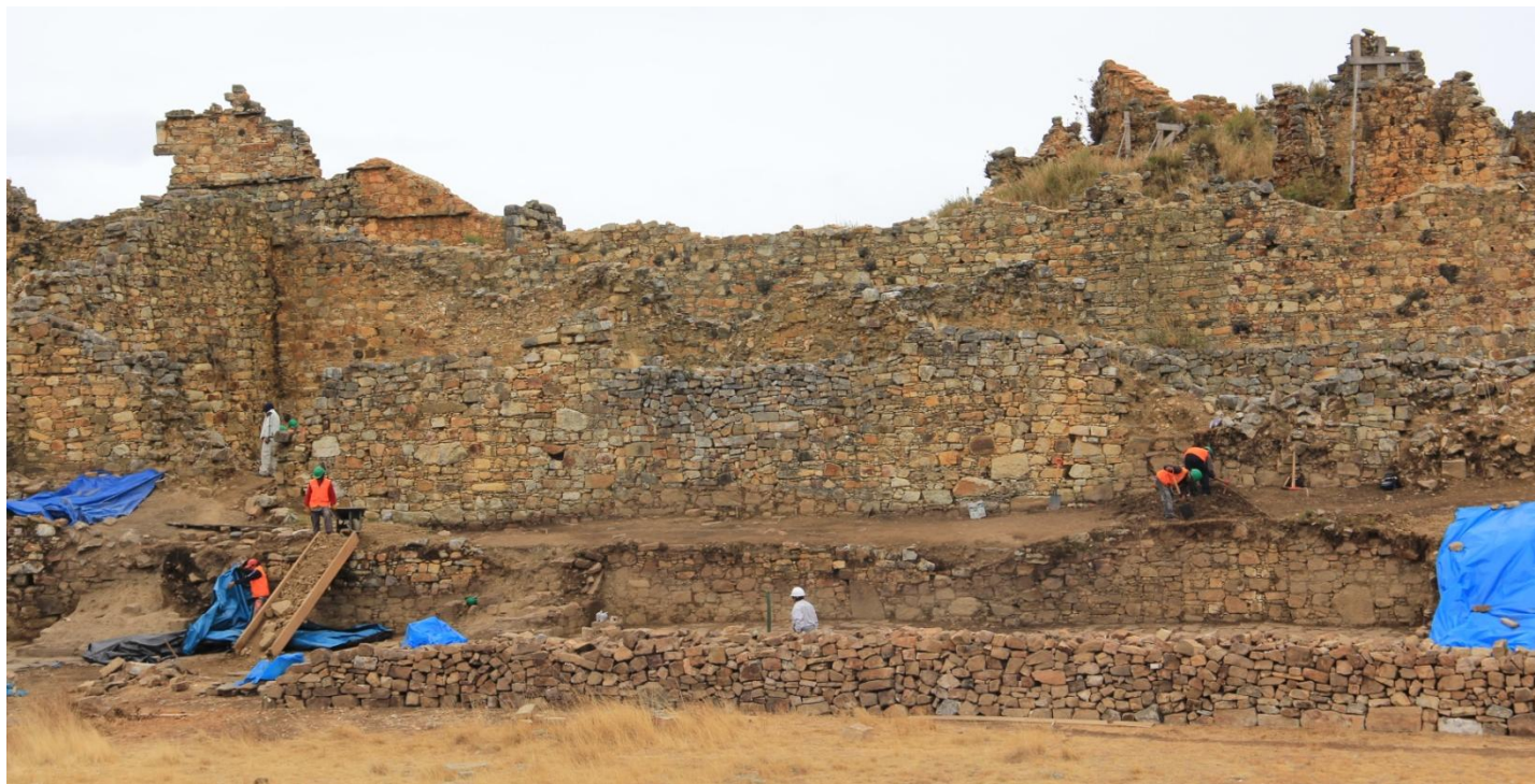
Vista general de las obras de restauración y puesta en valor del Complejo Arqueológico Marcahuamachuco.
