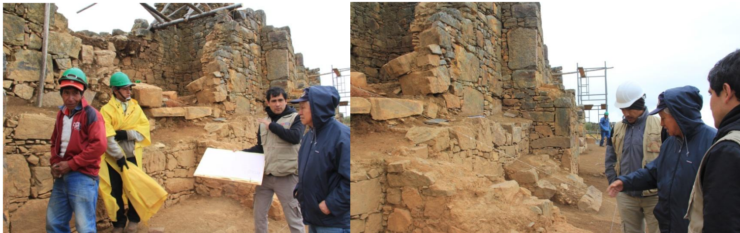
Vistas de los trabajos de restauración del Complejo Arqueológico Marcahuamachuco.
