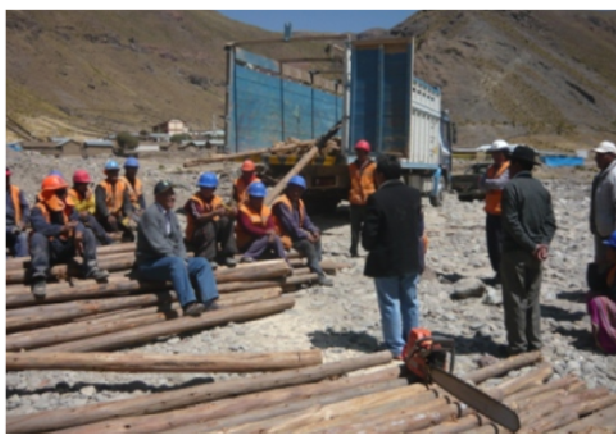
En el entretiempo inspeccionó las obras que realiza la Municipalidad Distrital de Ichuña, como el puente de concreto sobre el río acompañado del Alcalde del Distrito Pedro Cuela. (27.08.2010)
