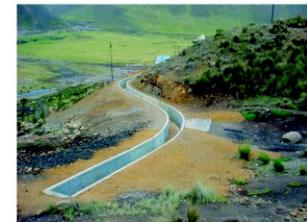
Obras mejora drenaje superficial de aguas de los depósitos de trióxido de arsénico de Vado y Malpaso. (obra concluida actualmente se desarrolla labores de mantenimiento).
