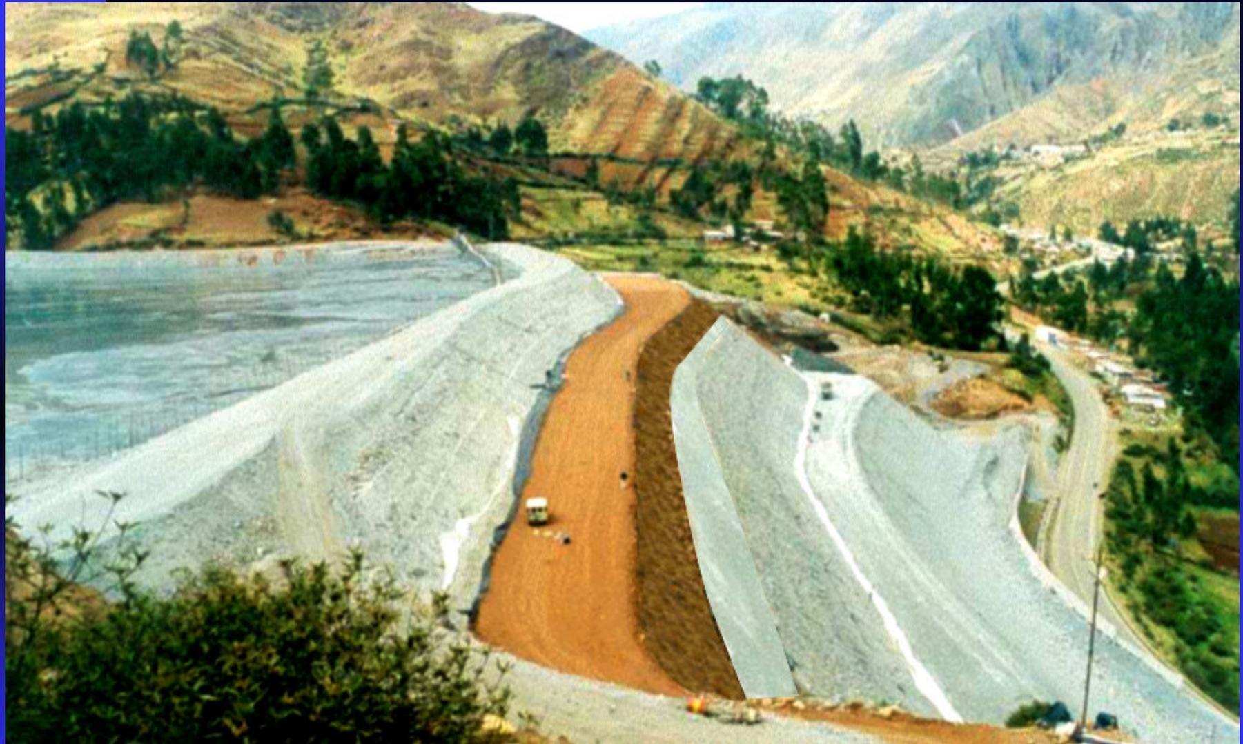
*CONSTRUCCION DEL NUCLEO Y ESPALDON AGUAS ABAJO EL 04 DE OCTUBRE DEL 2001*
