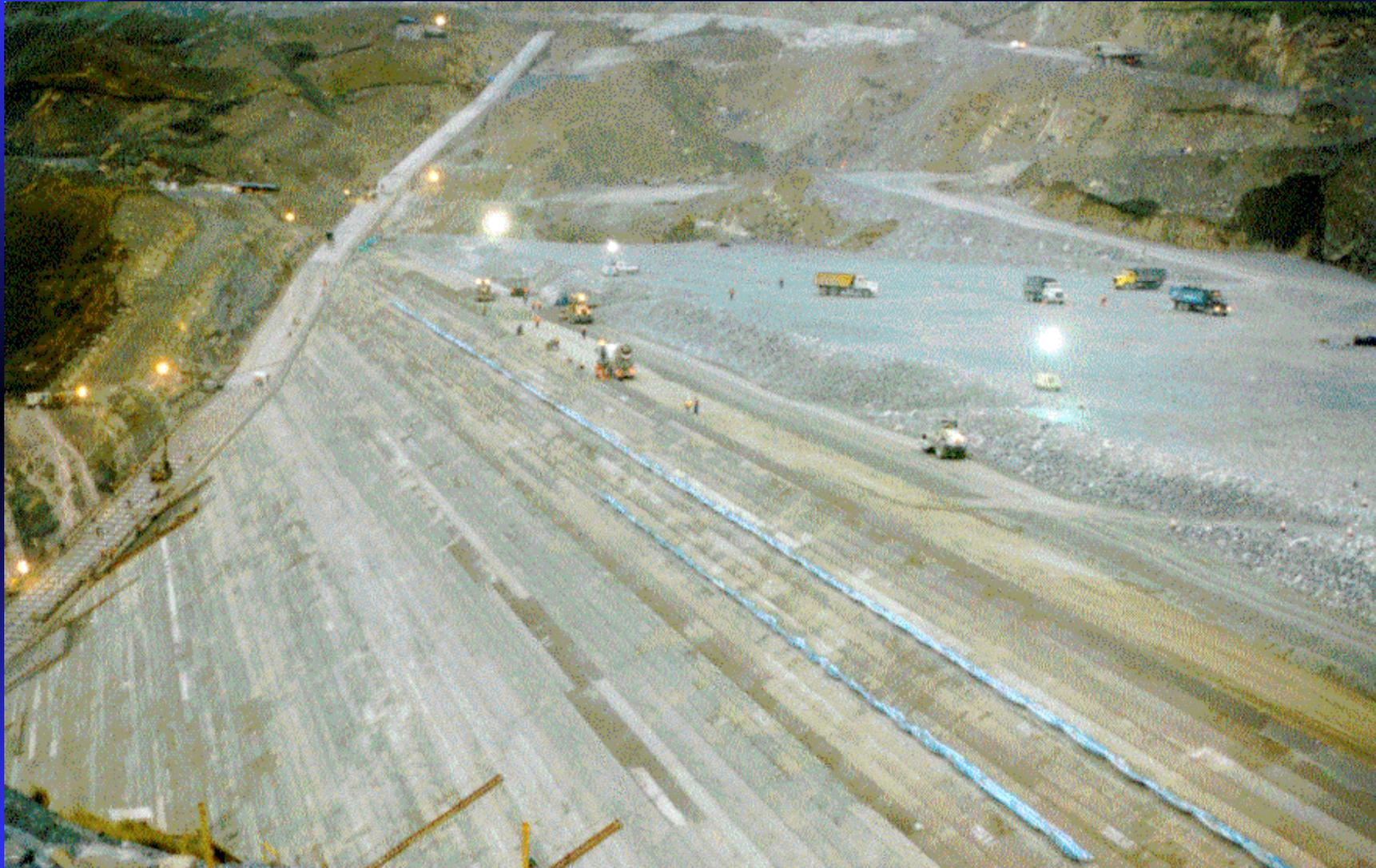
**Vista de la construcción del enrocado en el cuerpo de la presa y el talud aguas arriba**
