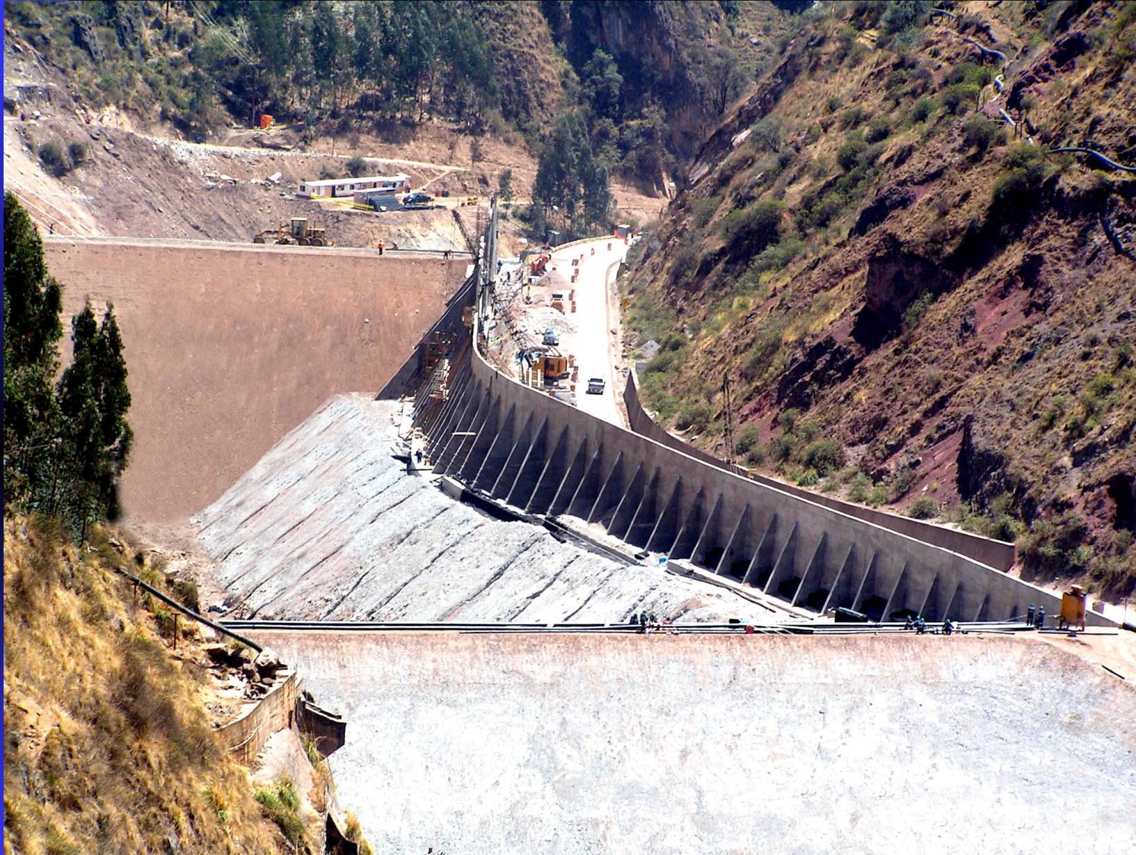
*CONSTRUCCION DEL NUCLEO Y ESPALDON AGUAS ABAJO EL 04 DE OCTUBRE DEL 2001*
