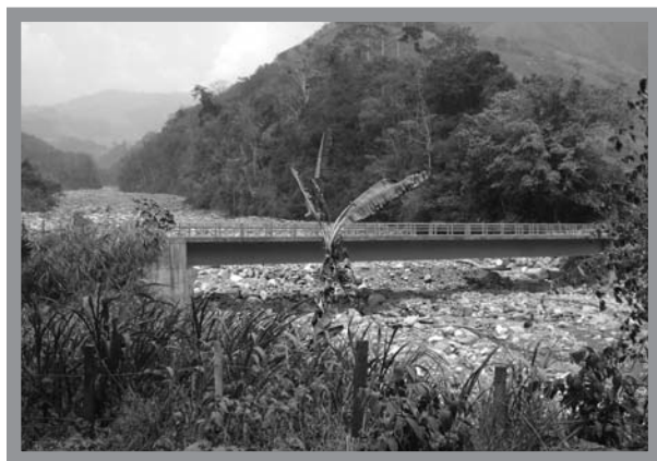
Puente Santa Rosa, ubicado en la vía Pozuzo (Pasco) – Codo de Pozuzo (Huánuco)
