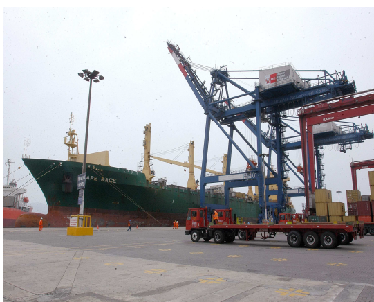
Una de las 2 Grúas Pórtico de muelle cuya operatividad incide en el mejoramiento del servicio (ENAPU)
