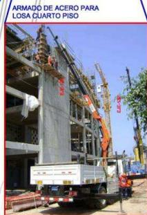
ARMADO DE ACERO PARA LOSA CUARTO PISO
