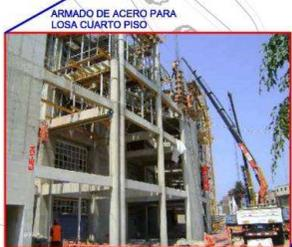
ARMADO DE ACERO PARA LOSA CUARTO PISO
