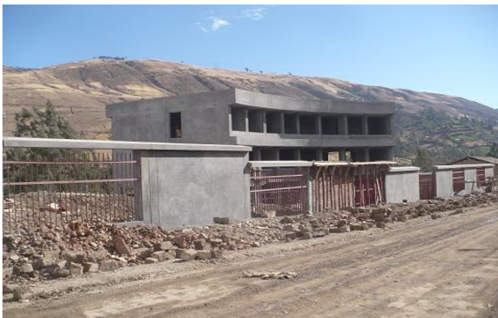
Congresista Antonio León Zapata verifica el acabado de la Construcción de Infraestructura Educativa de la Carrera Profesional de Ingeniería Agroindustrial de la Universidad Nacional José María Arguedas
