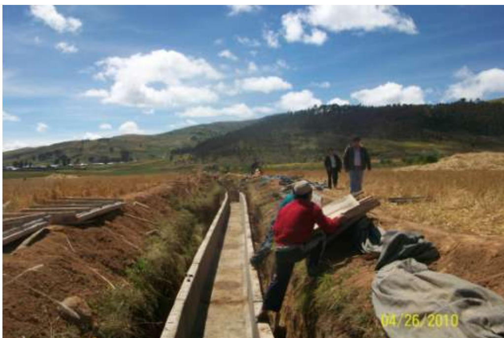
Congresista Antonio León Zapata verifica la Construcción y mejoramiento del canal de riego Ñahuin Pampanza verificando la revestida de concreto de forma rectangular con una longitud total de 10.145 Km
