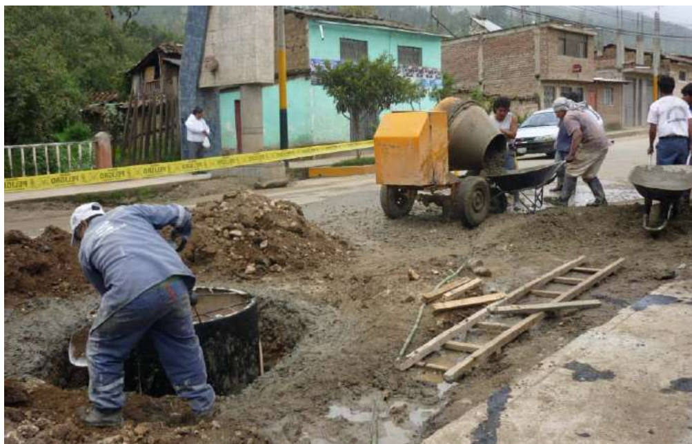
Congresista Antonio León Zapata verifica la construcción de buzones en la calle Leoncio Prado
