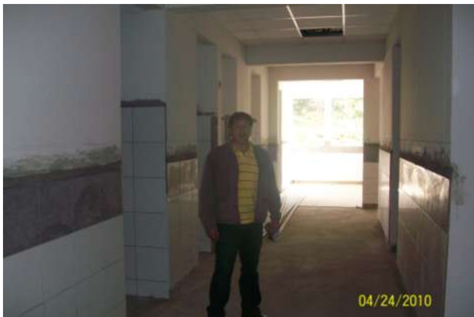
Inspeccionando la Construcción de la parte interna del Hospital de Chalhuanca conjuntamente con el representante de la Municipalidad de Chalhuanca
