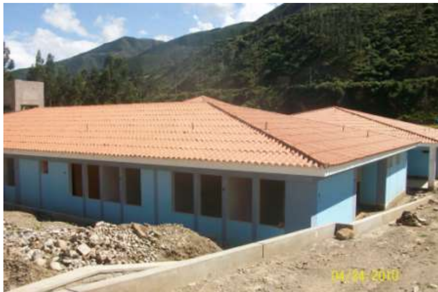
Inspeccionando la Construcción del la Infraestructura del Hospital de Chalhuanca
