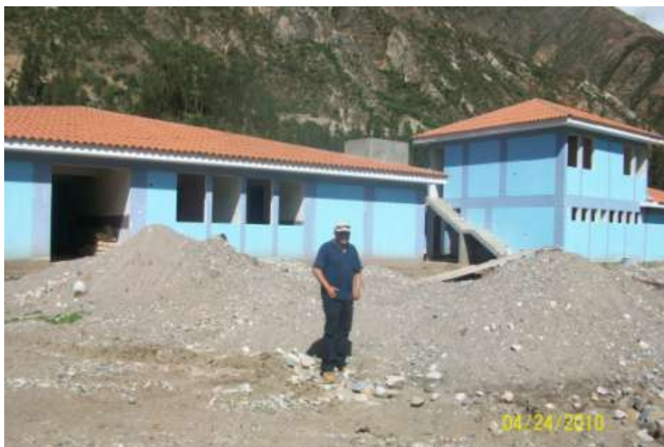
Verificando el Acabado de la Infraestructura del Hospital de Chalhuanca
