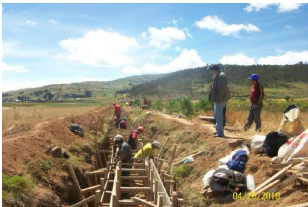
Congresista Antonio León Zapata Zapata la Construcción y mejoramiento del canal de riego Ñahuin Pampanza de las comunidades campesinas de Cumanaylla, Patacocha, Ccollpa, Chaccara, Tapaya, Pamapanza y Huamanaylla del distrito provincia de Andahuaylas,
