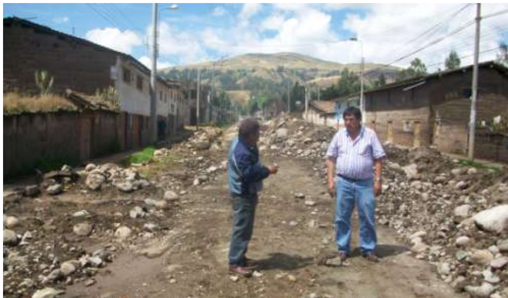
Congresista Antonio León Zapata Dialogando con el Supervisor de Obra el Ingeniero Efraín Altamirano sobre el avance físico de la obra Ampliación y mejoramiento del servicio de agua potable y alcantarillado de la localidad de San Jerónimo
