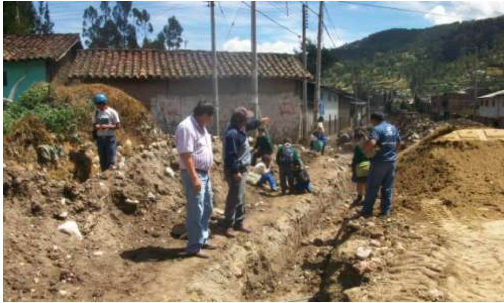
Congresista Antonio León Zapata conjuntamente Con el residente de la Obra el Ingeniero Oscar Delgado Flores y el Supervisor de Obra el Ingeniero Efraín Altamirano verifican la Instalación de tuberías de Agua y desagüe de la obra Ampliación y mejoramiento del servicio de agua potable y alcantarillado de la localidad de San Jerónimo
