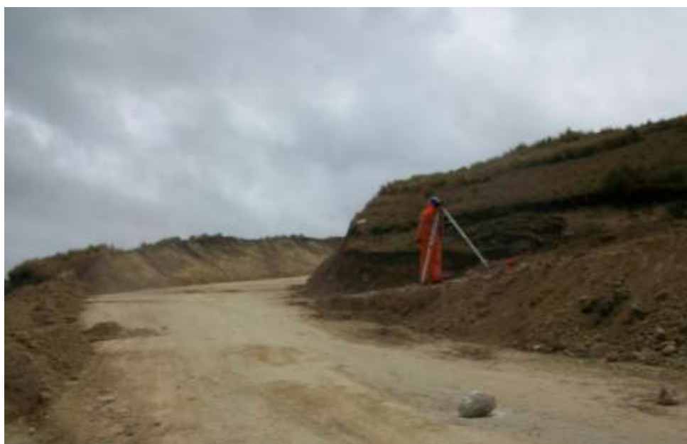
Congresista Antonio León Zapata Conjuntamente verifica el avance de la Obra del Asfaltado de la carretera Ayacucho – Abancay, TRAMO: 5 Sector II
