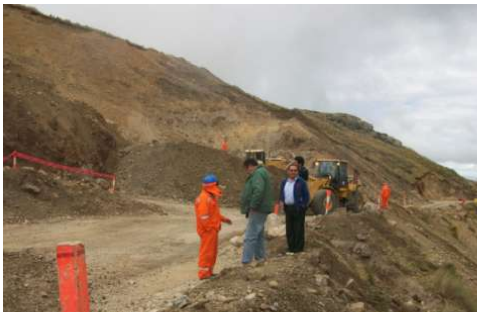
Congresista Antonio León Zapata Conjuntamente con el Ing. Residente Jorge Suazo verificando el avance de la Obra del Asfaltado de la carretera Ayacucho – Abancay, TRAMO: 5 Sector II
