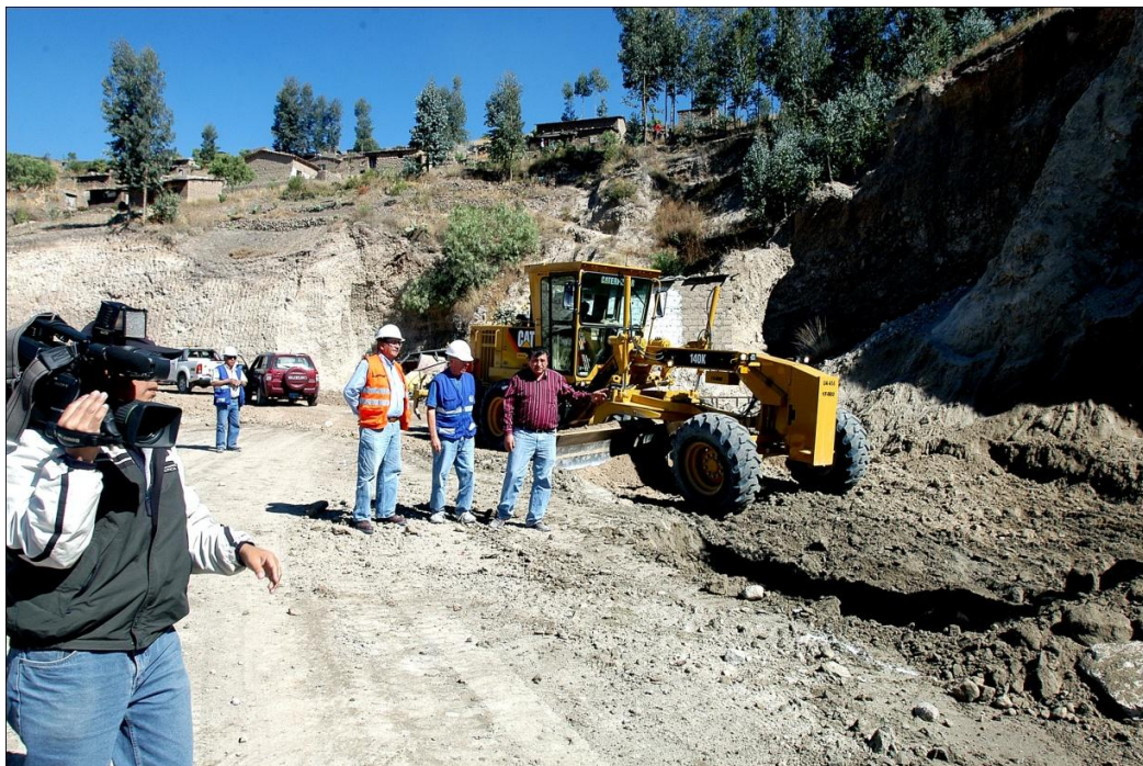
Congresista Antonio León Zapata conjuntamente con Supervisor de HOB y el Ingeniero Residente verifican los trabajos de ensanchamiento de la carretera y los Cortes de plataforma están ejecutados y los trabajos de mejoramiento de subrasante. En el Km. 14 de la carretera.
