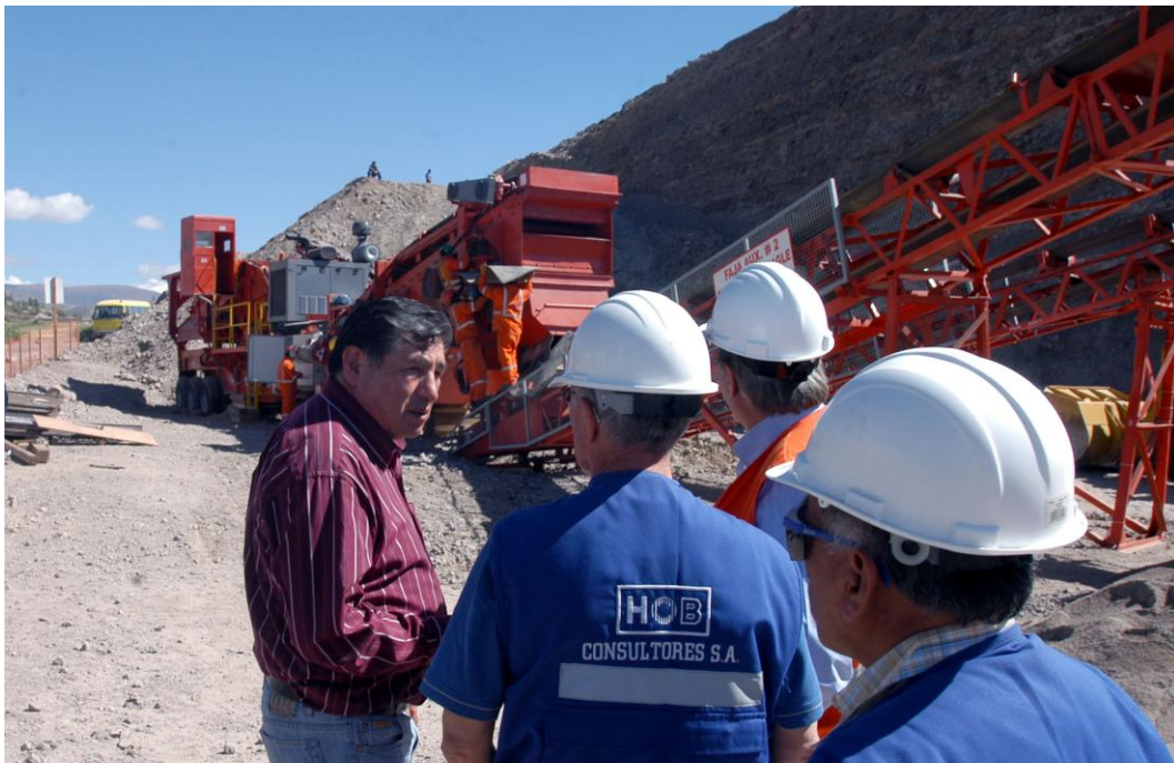
Congresista Antonio León Zapata conjuntamente con Supervisor de HOB y el Ingeniero Residente verifican los trabajos una de las canteras de donde se extraerá material de Sub Base para el asfalto de este tramo.
