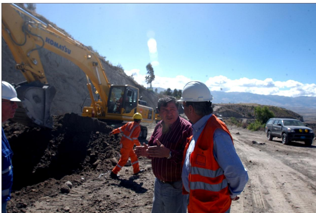
Supervisor de HOB indica al Congreso Antonio León Zapata sobre los trabajos de ensanchamiento de la carretera y los Cortes de plataforma están ejecutados y los trabajos de mejoramiento de subrasante.
