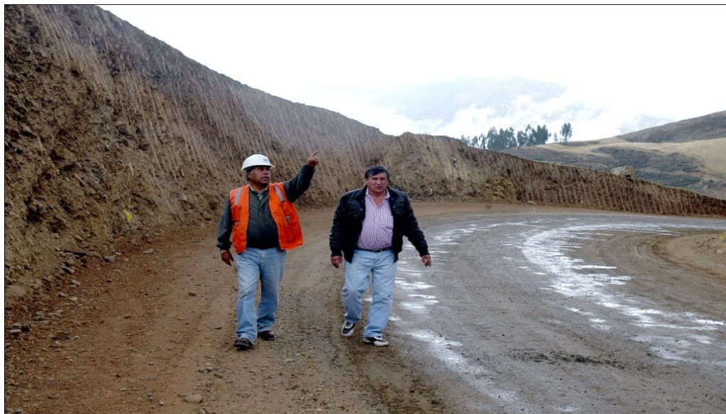
Congresista Antonio León Zapata supervisando los trabajos realizados por la Constructora JJ C Contratistas generales SA Como son Los Cortes de plataforma.
