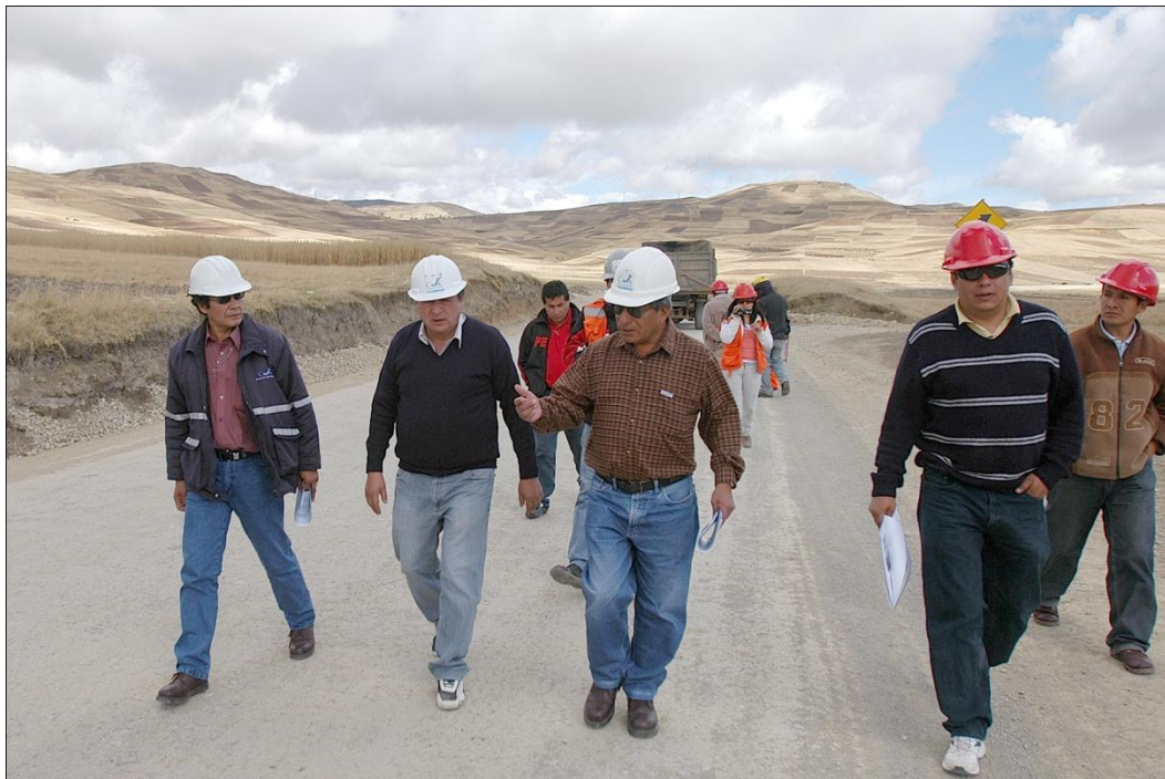
Congresista Antonio León Zapata, conjuntamente con el Ingeniero Residente verifica y constata Los trabajos mejoramientos de terraplén y consistencia de la plataforma.
