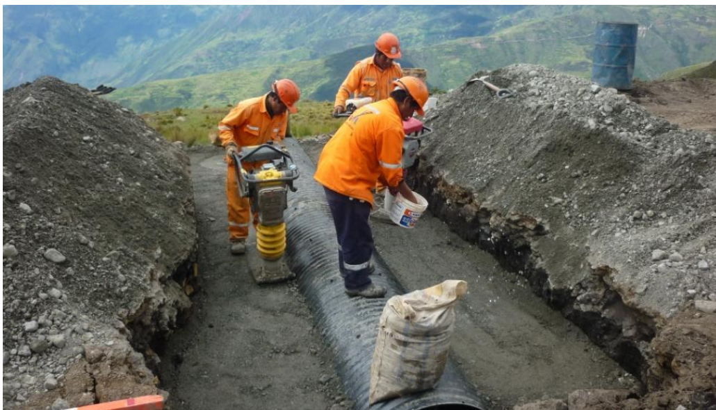
Congresista Antonio León Zapata verificando la colocación de alcantarillas tipo TMC de las cuales ya cuenta con un drenaje funcional
