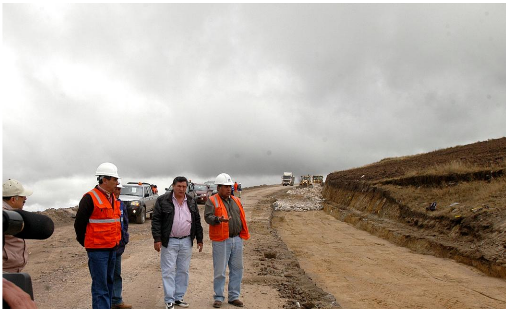
Congresista Antonio León Zapata, conjuntamente con el Supervisor de HOB y los Ingenieros de JJC verificando los trabajos de mejoramiento de subrasante.
