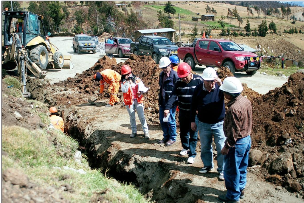
Congresista Antonio León Zapata verificando la colocación de drenajes en zonas de alta humedad y así mantener en buen estado la carretera.
