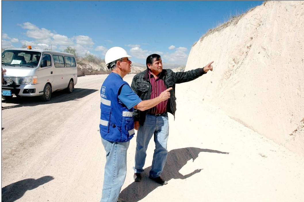
Supervisor de HOB indica al Congresista Antonio León Zapata sobre los trabajos de ensanchamiento de la carretera y los Cortes de plataforma están ejecutados
