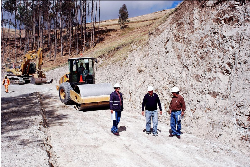
Congresista Antonio León Zapata, conjuntamente con el Ingeniero Residente verifica y constata Los trabajos de corte de talud se encuentran ejecutados al 95%
