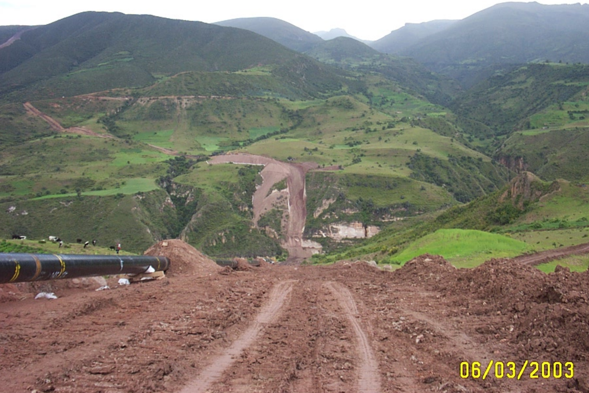
Vista panorámica del cruce del Río Yucay
