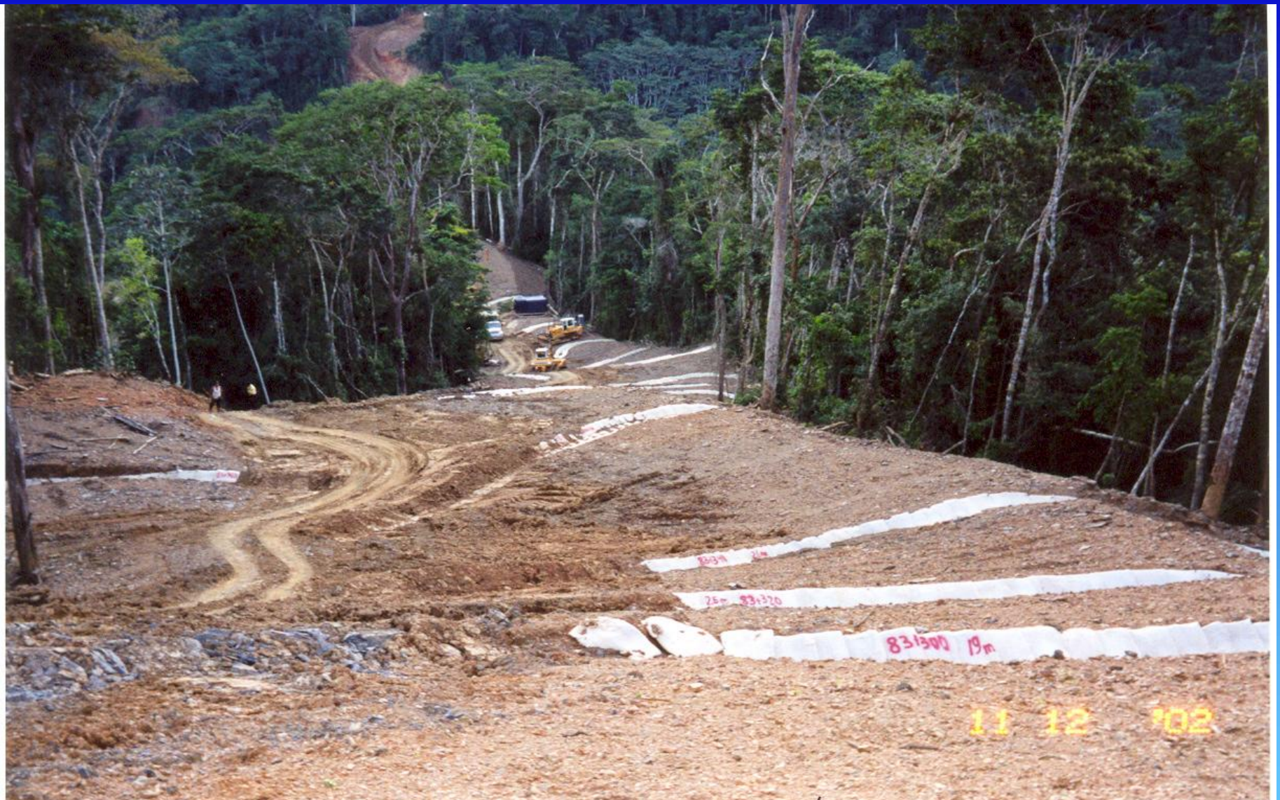
KP 83+300 al KP 83+800 cortacorrientes para control de erosión en el Derecho de Vía - sector de Chimparina
