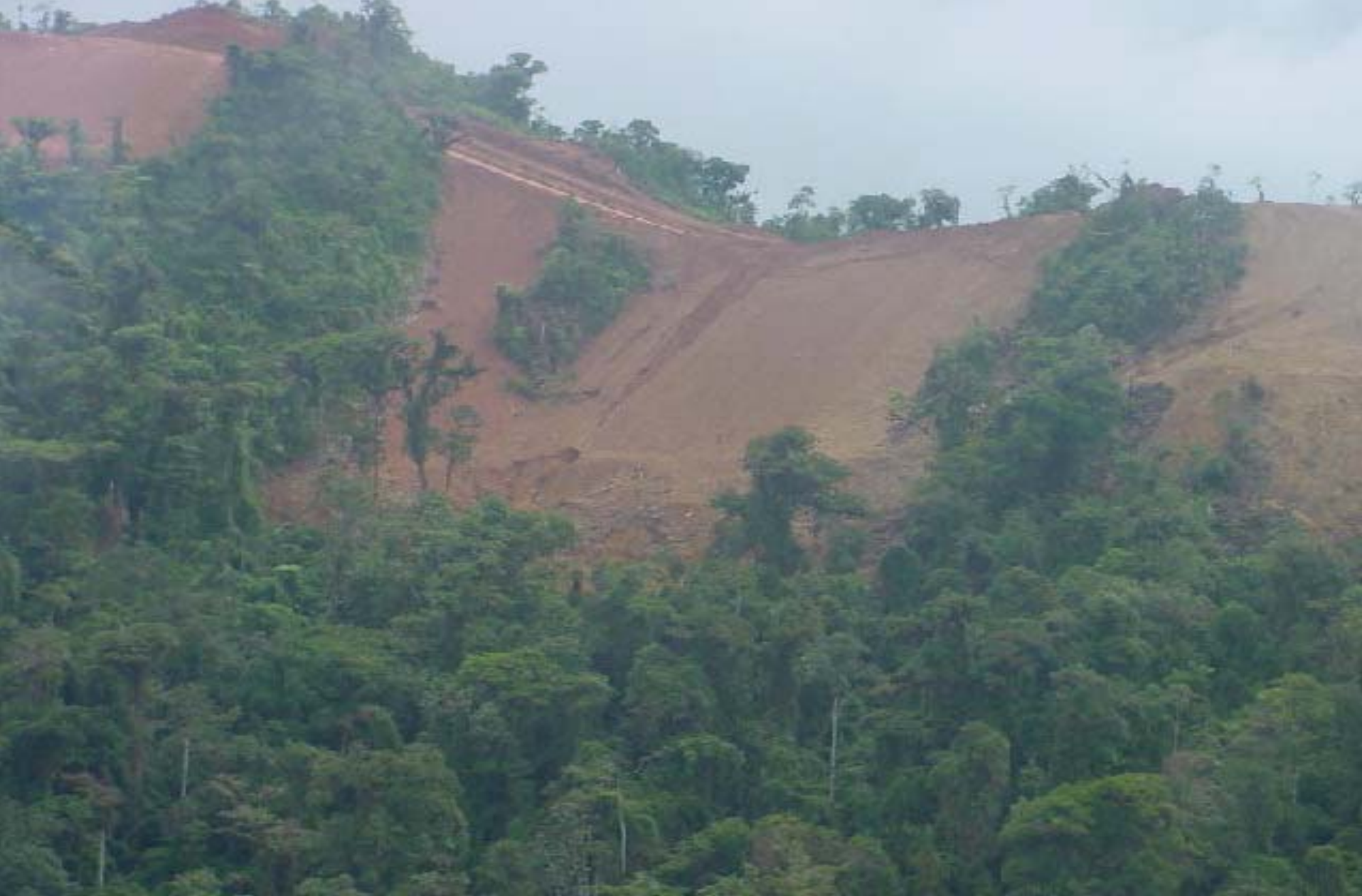
PK-138+900 Problemas de erosión de taludes en la ruta de Segakiato - Comerciato
