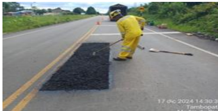
Hueco km 348+015 (después)
