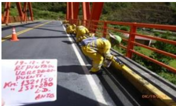
Repintado veredas puente km 132+150 (antes)
