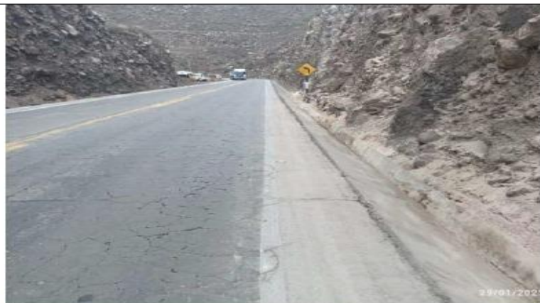
Sector : 04 Descripción : Limpieza de Cunetas Progresiva : 64+600 LD.
