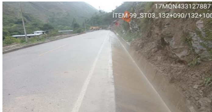
Cuneta obstruida km 132+090: Cochabamba-Chota (después)
