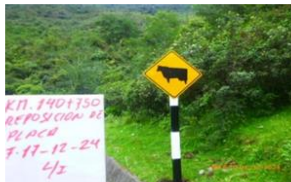
Deterioro del mensaje de las placas de señales km 140+750 (después)
