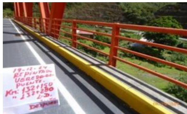
Repintado veredas puente km 132+150 (después)
