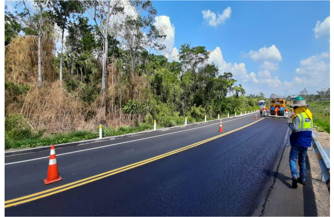
Después – Intervención del pavimento (ITM)
