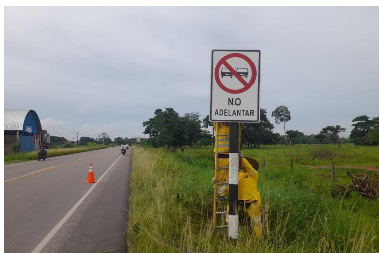
Limpieza de Placas de Señalización
