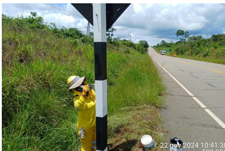
Repintado de poste de señal
