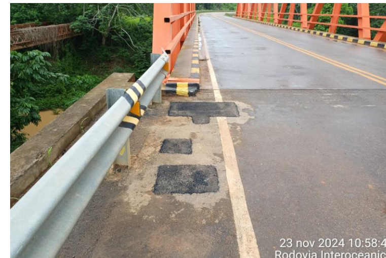
Reparación de bache
