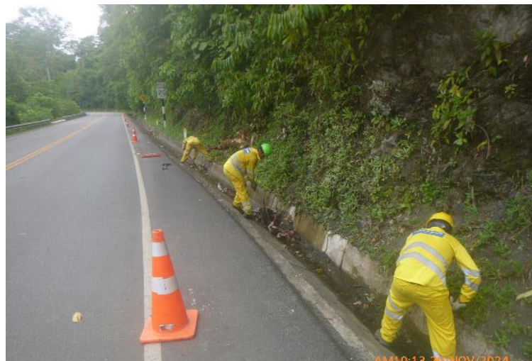
Limpieza de cuneta de vía
