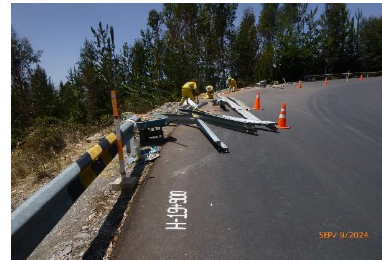
Reposición de guardavías
