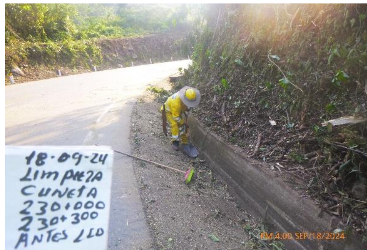
Limpieza de cuneta de vía
