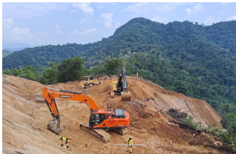
ESTABILIZACIÓN CON BANQUETAS
