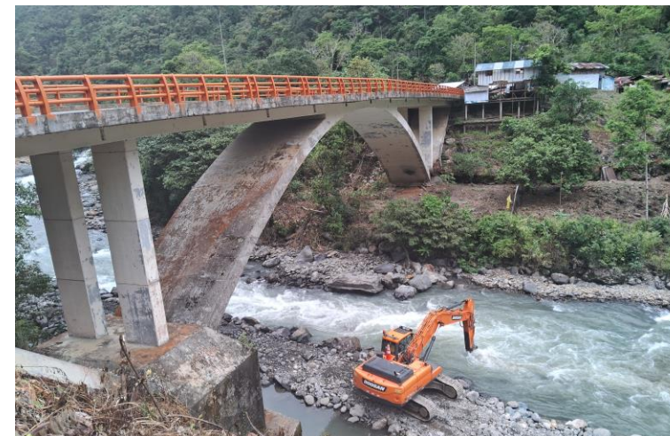
CONSTRUCCIÓN ATAGÍA EN ESTRIBO
