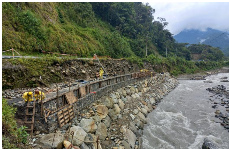
CONSTRUCCIÓN MURO GAVIÓN
