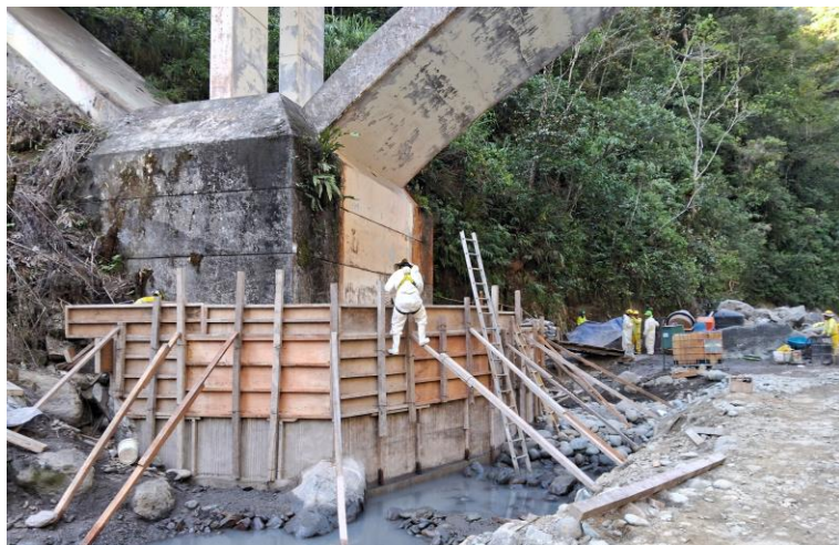
CALZADURA EN PUENTE
