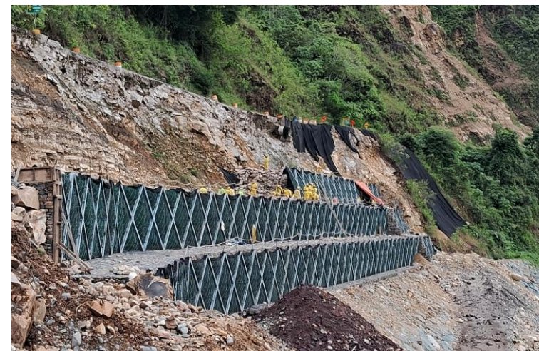
ESTABILIZACIÓN CON ERDOX
