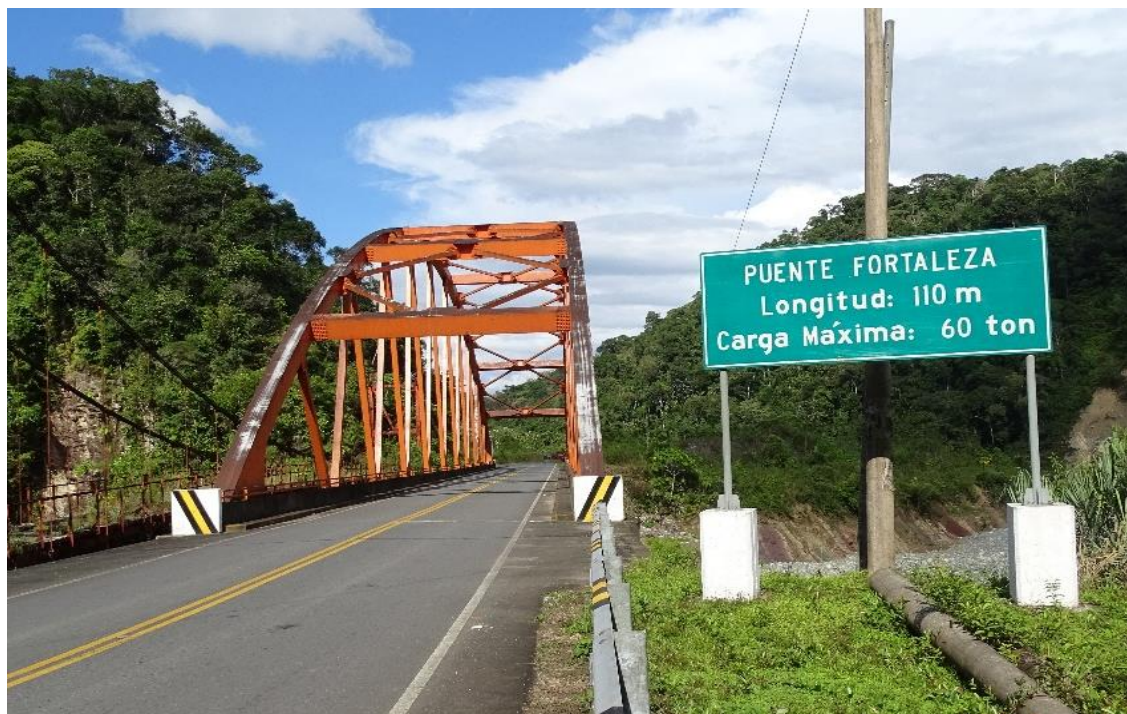
Antes – Desgaste de pintura
