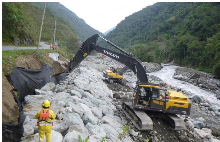
CONSTRUCCIÓN DE ENROCADO
