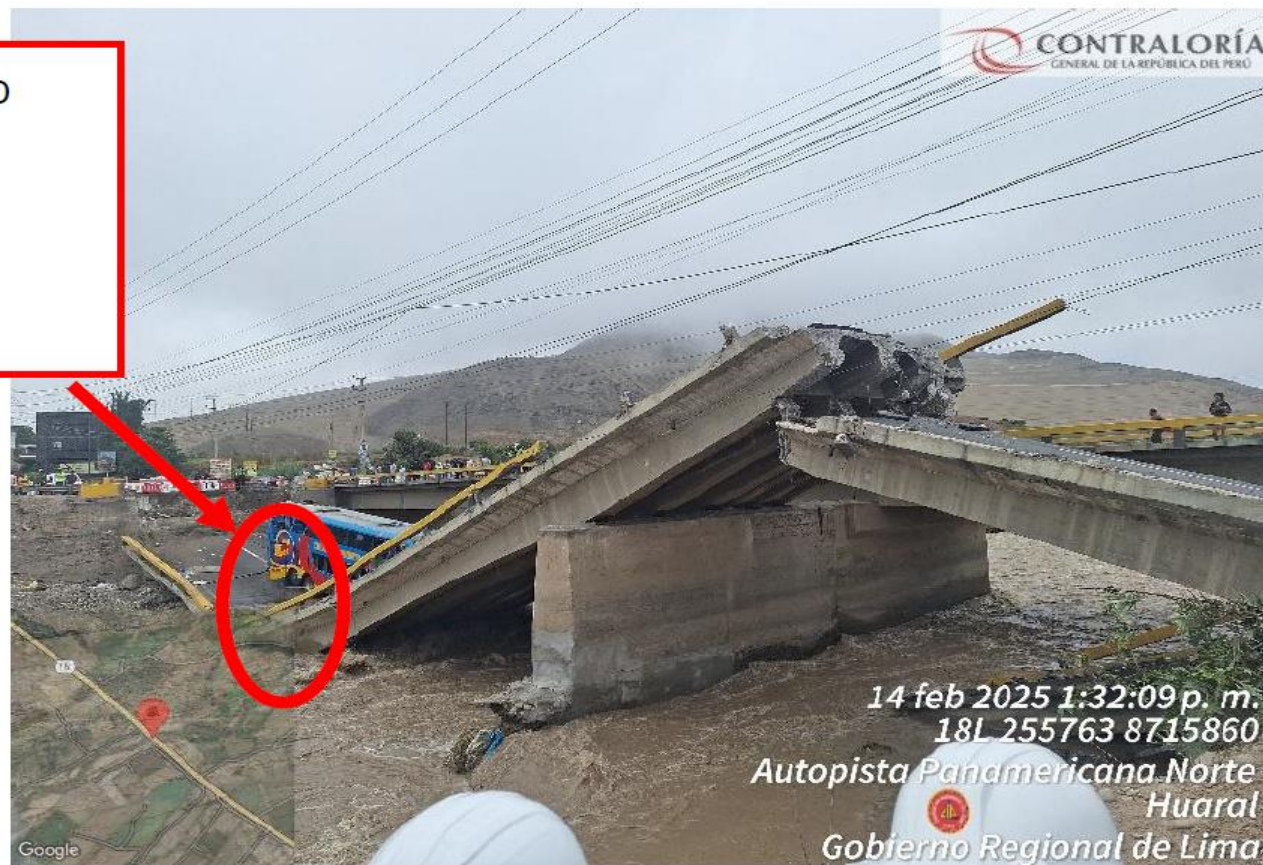
Imagen N°04. Pilar intermedio del Puente “Chancay” colapsado
