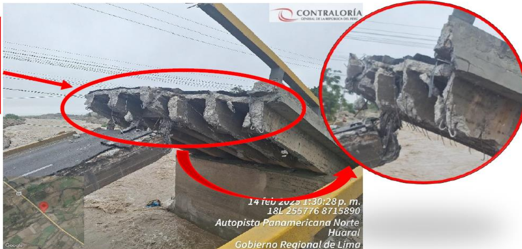
Imagen N°02. Tablero del Puente “Chancay” fracturado con refuerzo de acero expuesto
