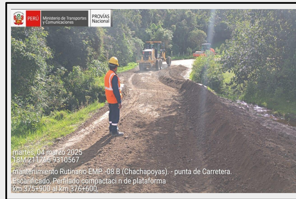
Perfilado de plataforma sin aporte de material
