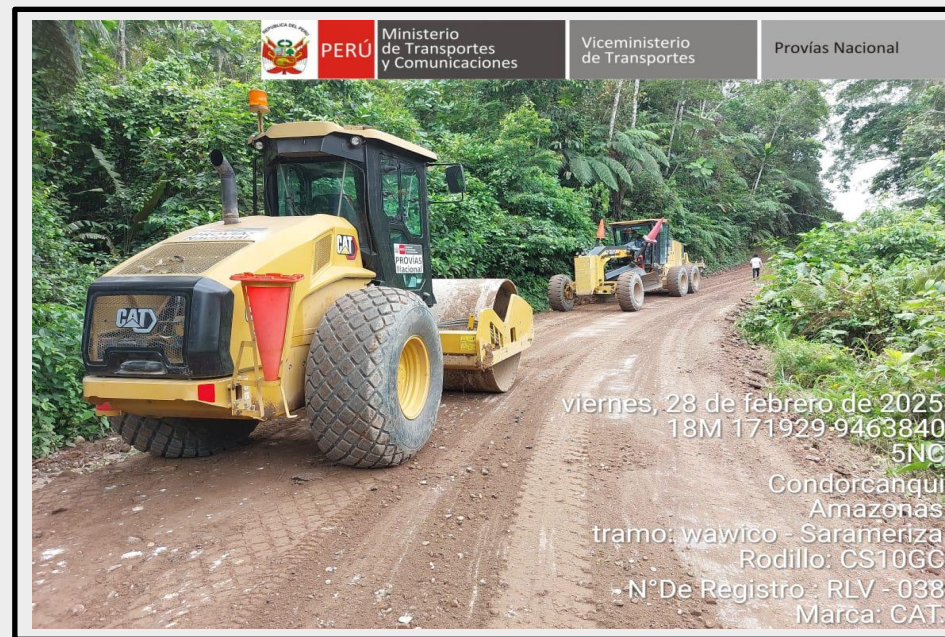
Compactado y enrasado de superficie de rodadura
