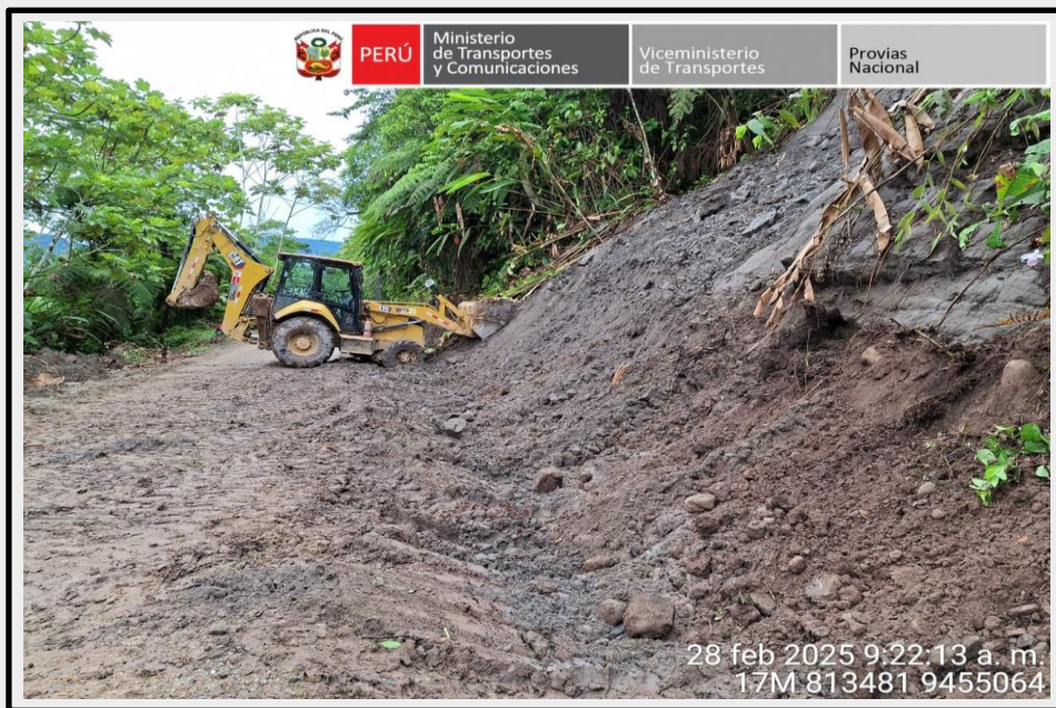
Eliminación de derrumbes menores.
