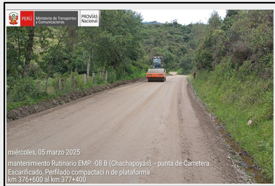
Compactado de la superficie de rodadura
