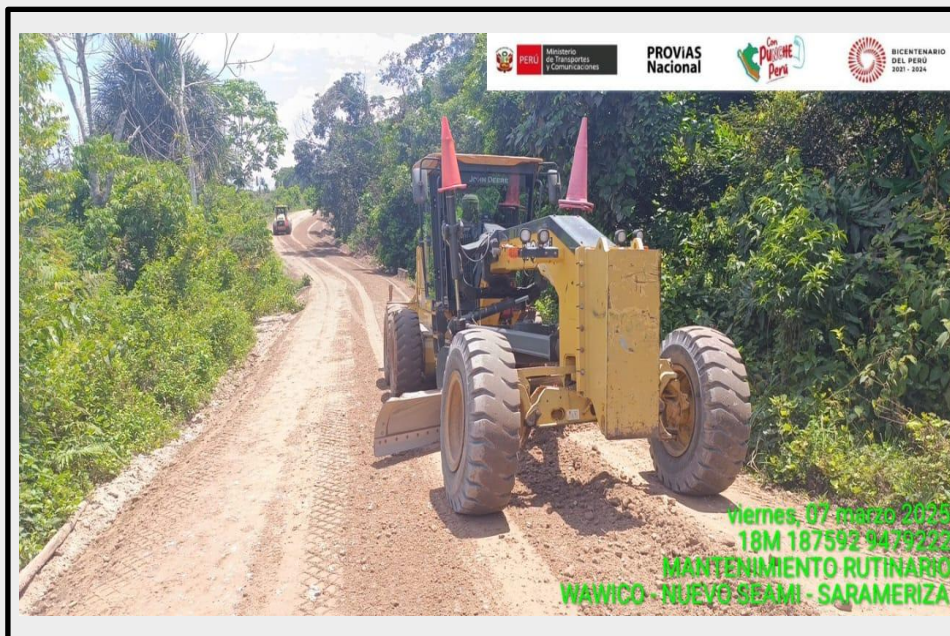
Perfilado de plataforma.
