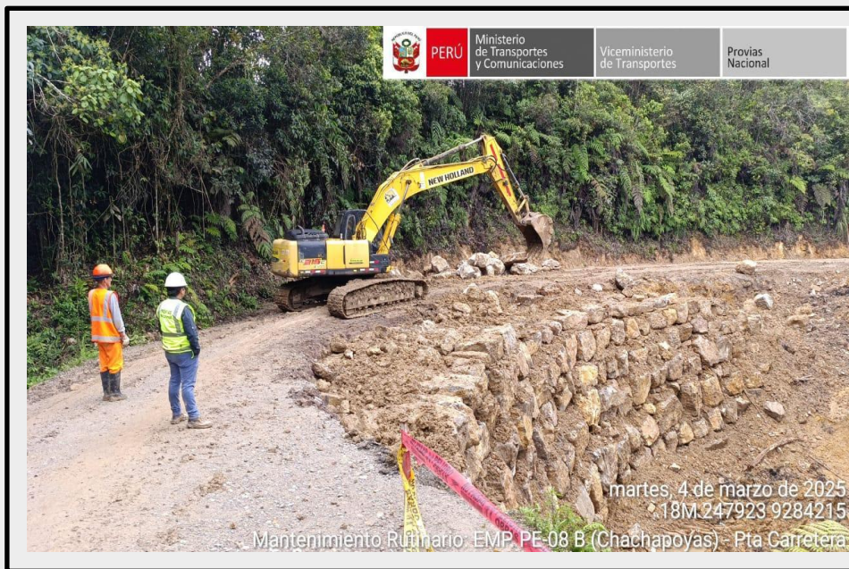
Reparación de muro seco
