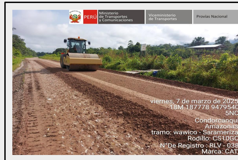
Compactado de superficie de rodadura
