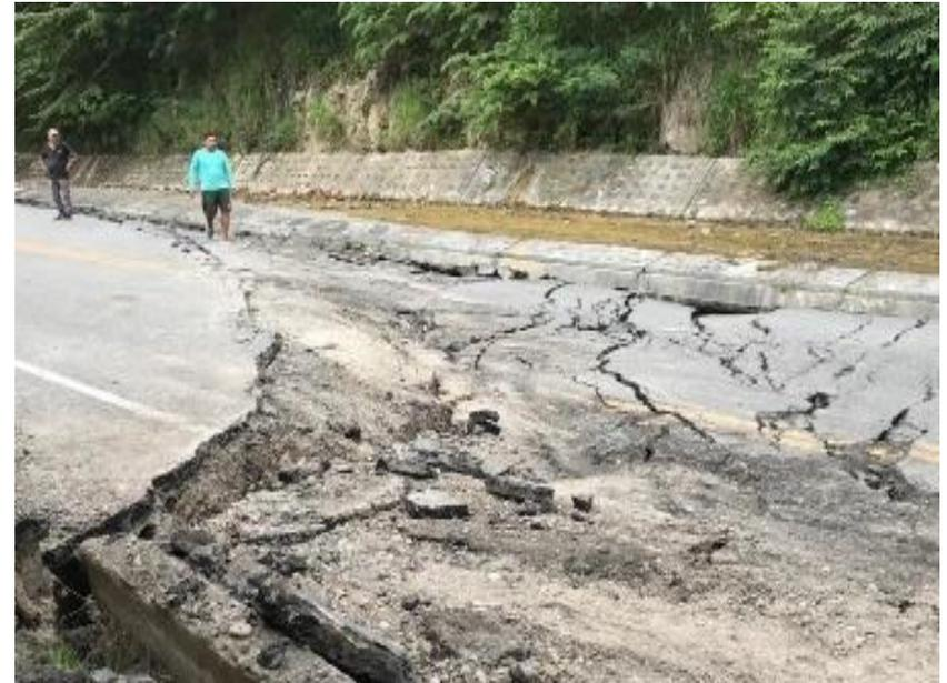
Principales afectaciones por el sismo fueron la pérdida de cerca de 5 kms de vía de la Variante Aserradero, la desestabilización de muchos taludes superiores en sectores sin antecedentes recientes de deslizamientos, el cambio de la naturaleza del flujo en las quebradas, como la del Puente La Caldera, ante el desplome de los taludes del cauce aguas arriba de los puentes o de alcantarillas.
