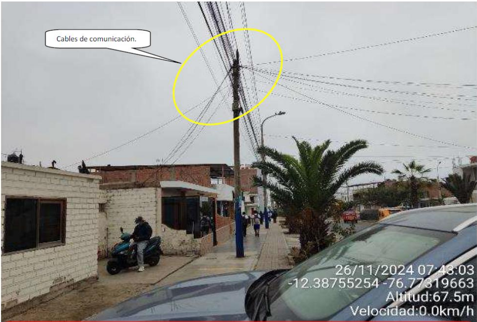
Foto 64. Cuadra dos de la Av. San José, el cableado aéreo que se observa corresponde exclusivamente a redes de comunicación la red eléctrica de baja tensión en esta zona es subterránea, coordenada: -12.38755254; -76.77319663.
