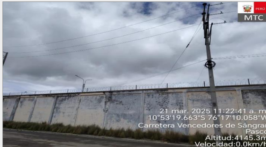
Instalación de fibra óptica
